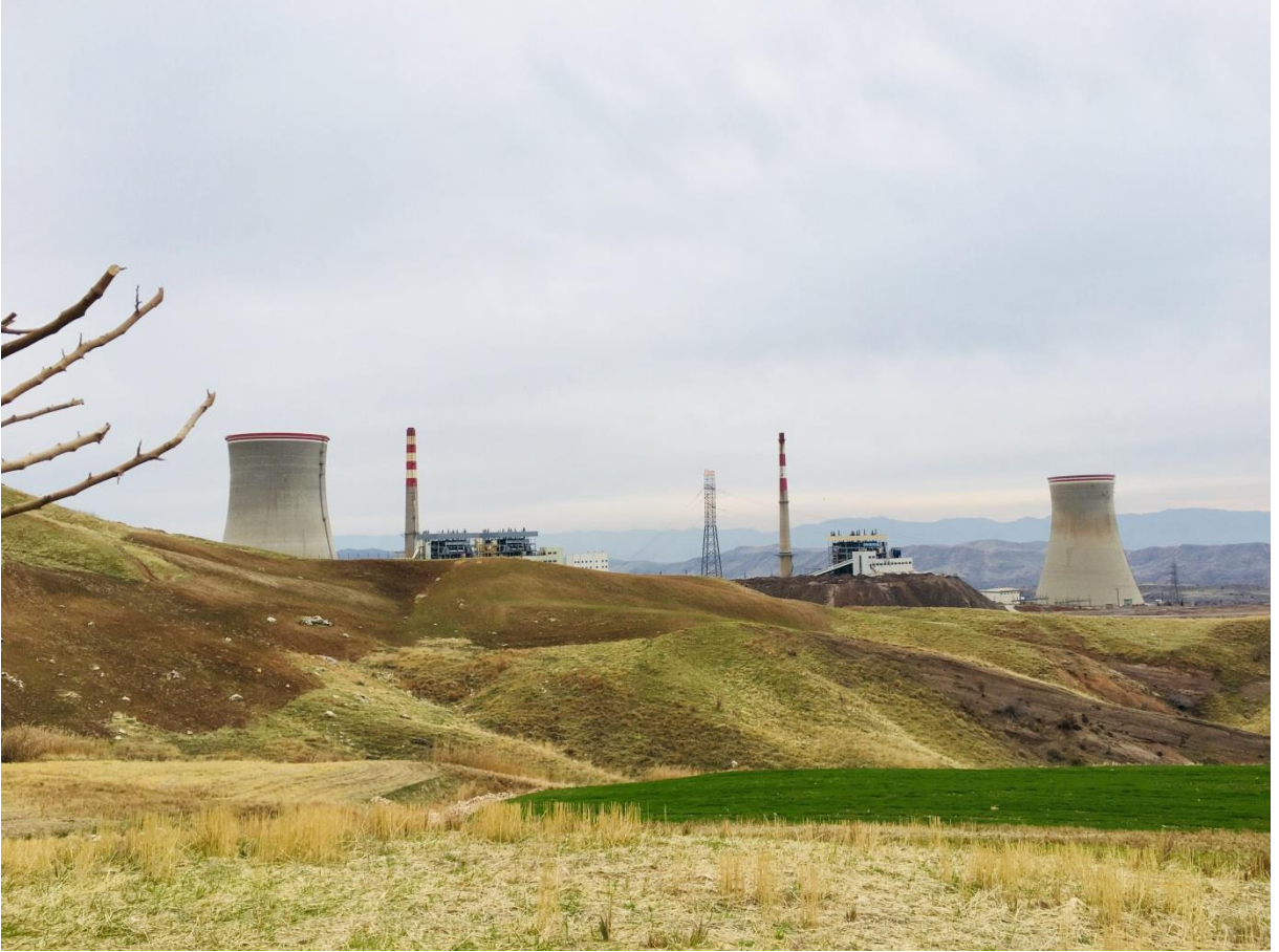
Fotoğraf C.2 - Silopi Elektrik Üretim A.Ş Termik Santrali (Silopi Elektrik Üretim A.Ş. Mayıs 2020)
