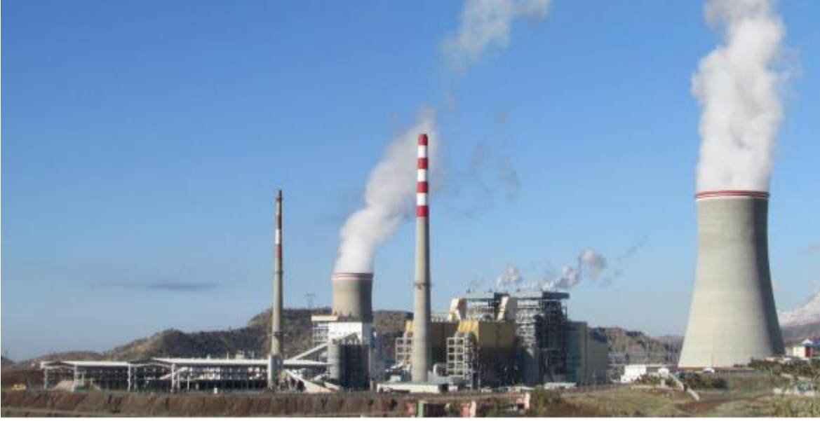
Resim 2 -Silopi Termik Santrali
