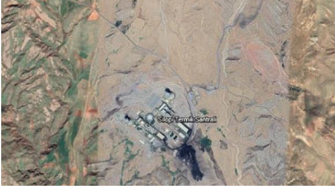
Harita 3 - Şırnak İli Silopi Termik Santrali
