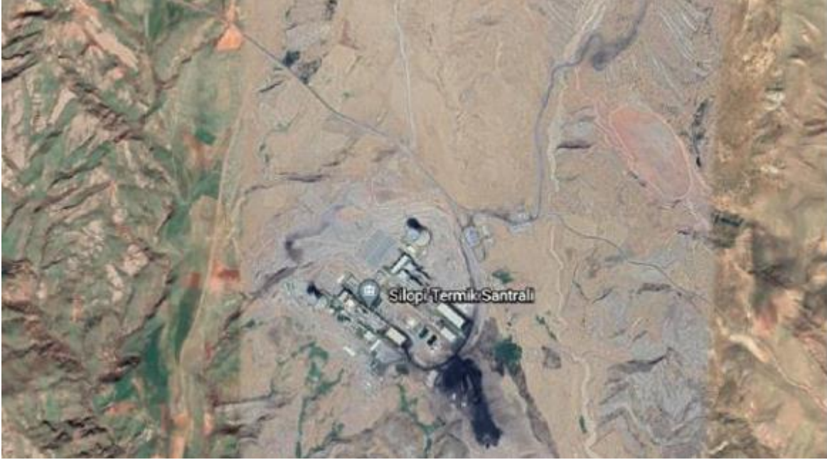
Harita 3- Şırnak İli Silopi Termik Santrali
