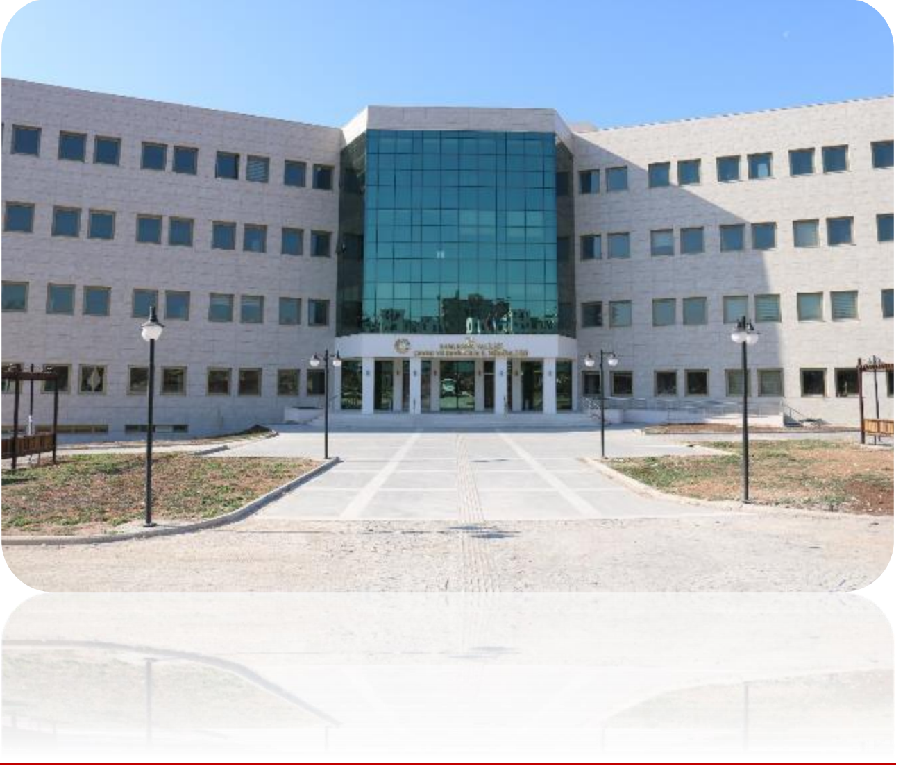
Resim 1 Müdürlüğümüz, 15.11.2019 tarihi itibari ile Mehmetçik Mah. 71. Cadde 7062. Sokak No:2 Karaköprü/Şanlıurfa adresindeki yeni İl Müdürlüğü binasında hizmet vermektedir. (ŞÇŞİDİM, 2024)
