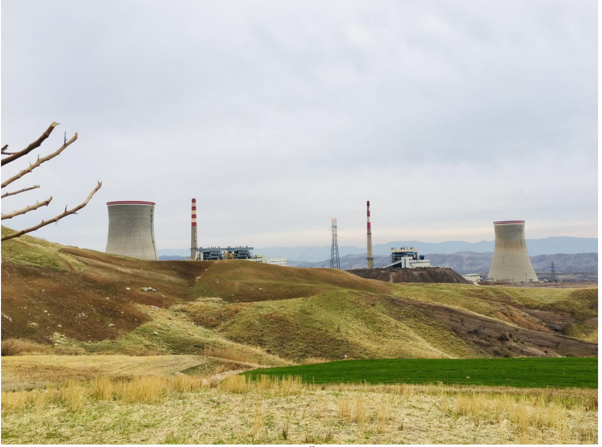
Fotoğraf C.2 – Silopi Elektrik Üretim A.Ş Termik Santrali (Silopi Elektrik Üretim A.Ş. Mayıs 2021)
