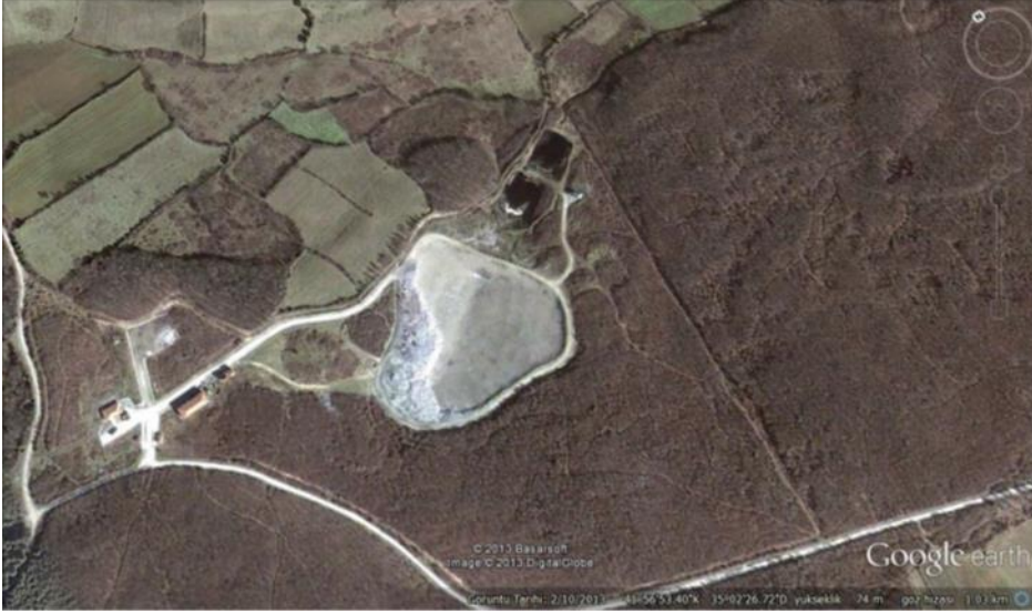
Şekil B.4 - Sinop Katı Atık Düzenli Depolama Tesisi
