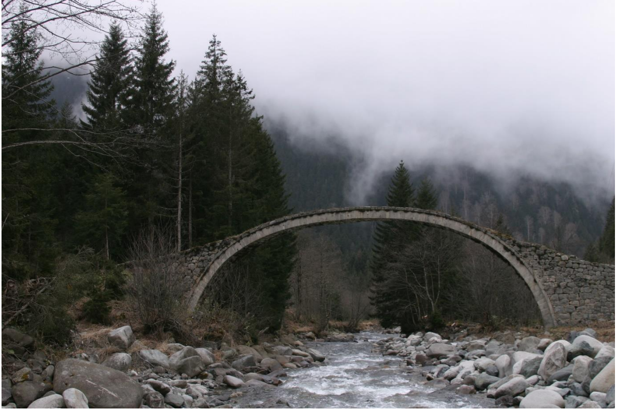
Resim 1- Çat (Çılanç) Köprüsü
