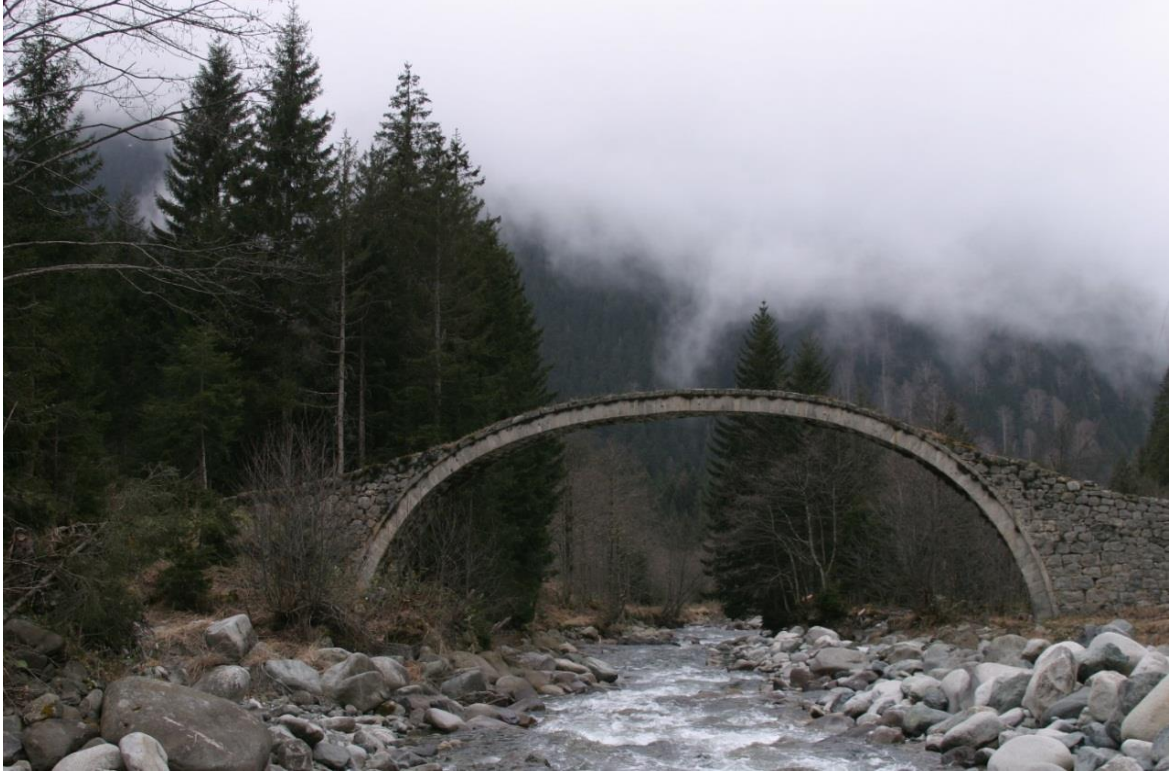
Çat (Çılanç) Köprüsü
