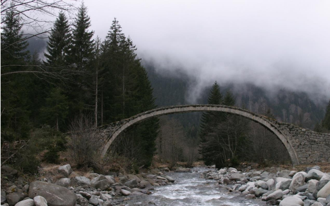
Çat (Çılanç) Köprüsü
