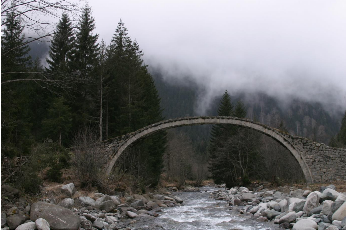
Çat (Çılanç) Köprüsü
