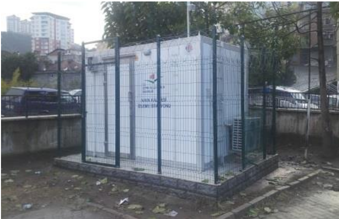
Resim A.1-Fatsa Hava Kalitesi Ölçüm İstasyonunun Yeri (Hava İzleme İstasyonu)
