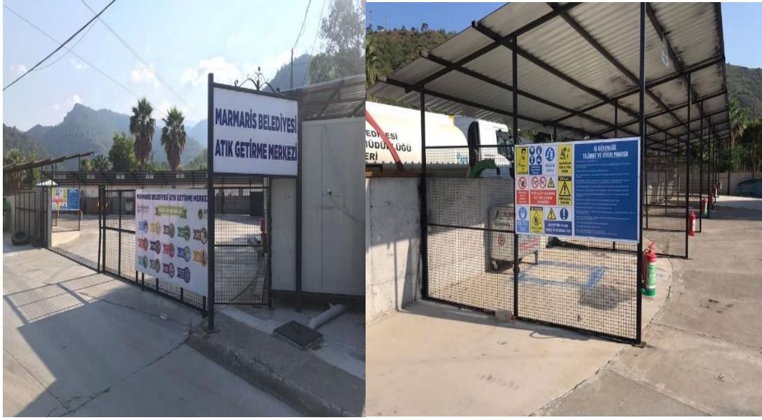
Şekil 8: Marmaris Belediyesi Atık Getirme Merkezi
