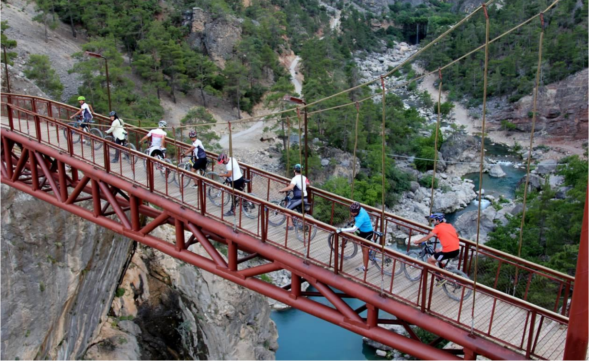
Resim D.62 - Yerköprü Tabiat Anıtı Köprü Geçişi
