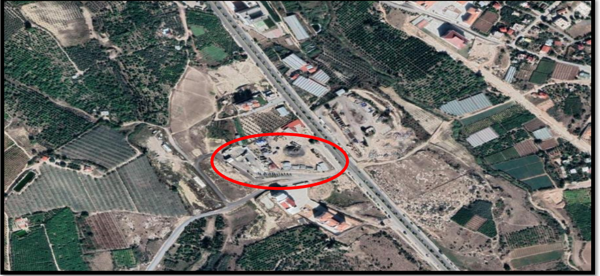
Harita C.5 – Mersin İli Yenişehir İlçesi Katı Atık Aktarma İstasyonu (Mersin Büyükşehir Belediye Başkanlığı Çevre Koruma ve Kontrol Dairesi Başkanlığı)
