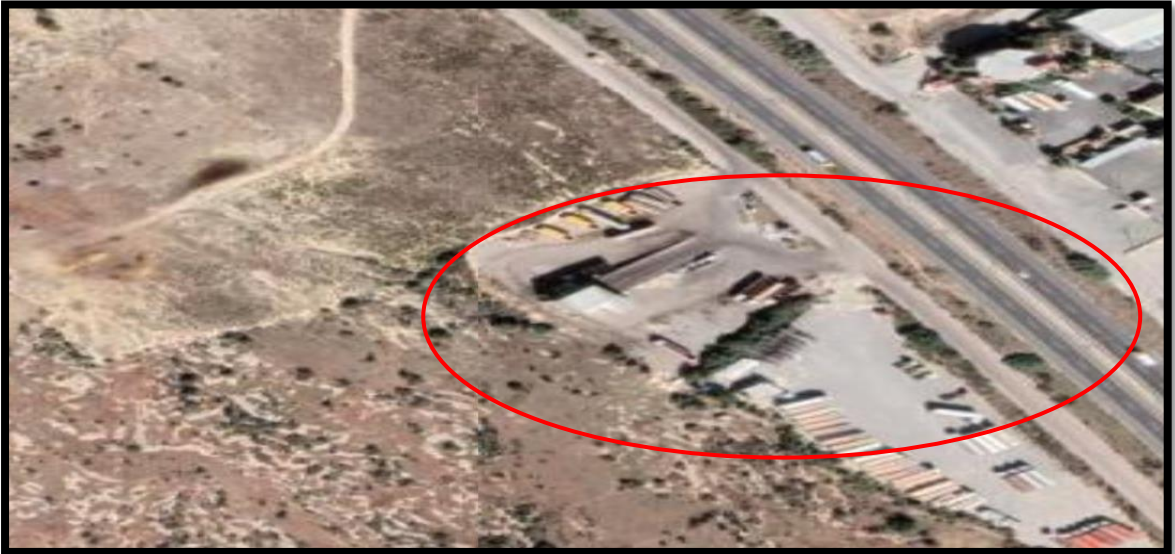
Harita C.6 – Mersin İli Toroslar İlçesi Katı Atık Aktarma İstasyonu (Mersin Büyükşehir Belediye Başkanlığı Çevre Koruma ve Kontrol Dairesi Başkanlığı)
