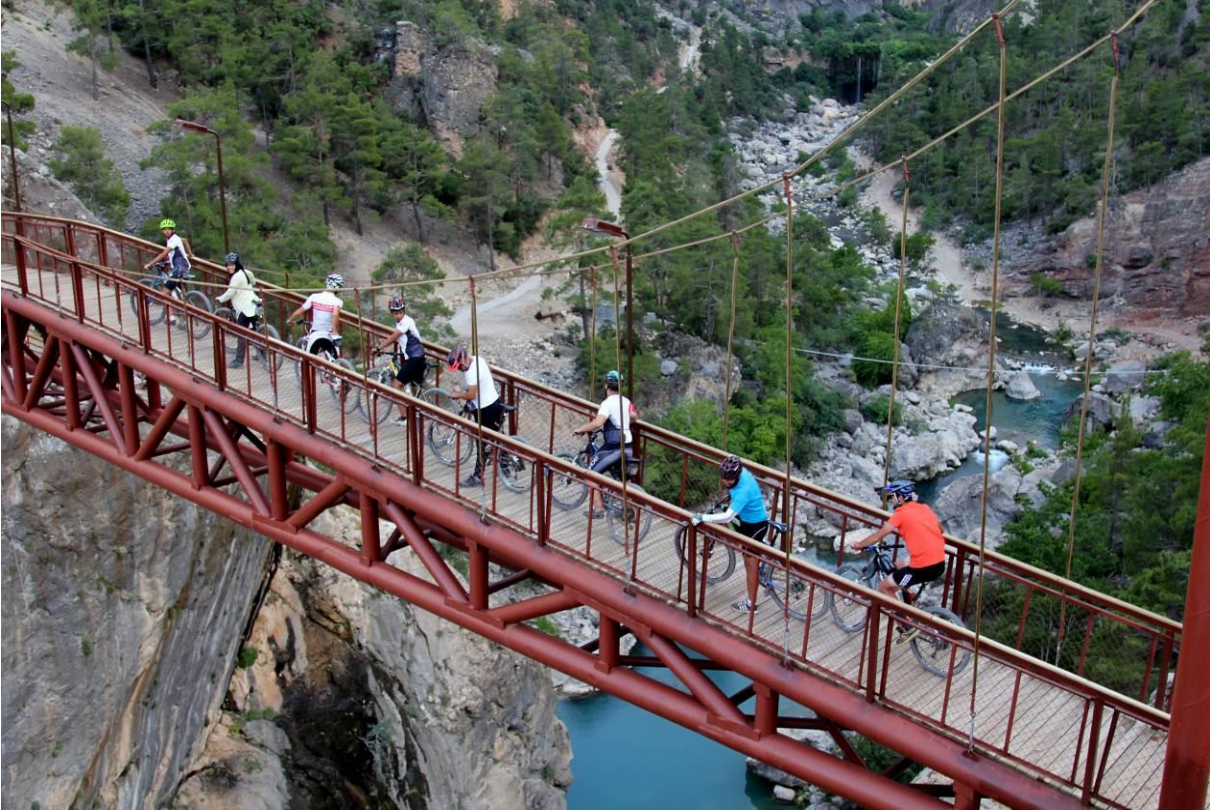
Resim D.59- Yerköprü Tabiat Anıtı Köprü Geçişi
