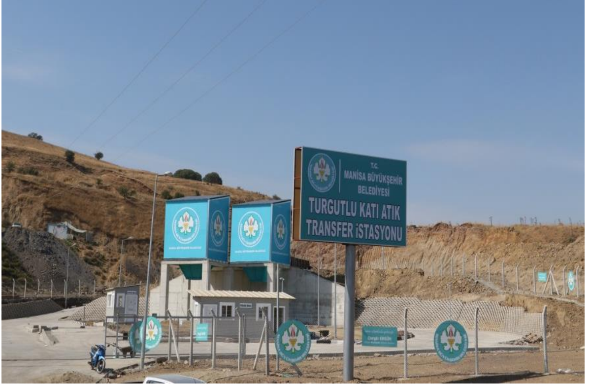
Resim C.2-Turgutlu İlçesi Katı Atık Transfer İstasyonu
