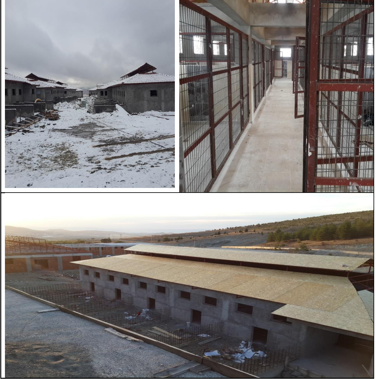
Resim D.6- Hayvan Bakım Evi
