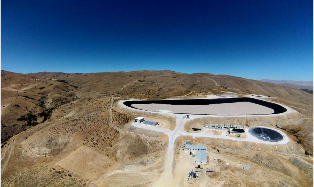
Resim C.3- İlimiz Katı Atık Bertaraf ve Düzenli Depolama Tesisi İnşaatından Görüntüler
