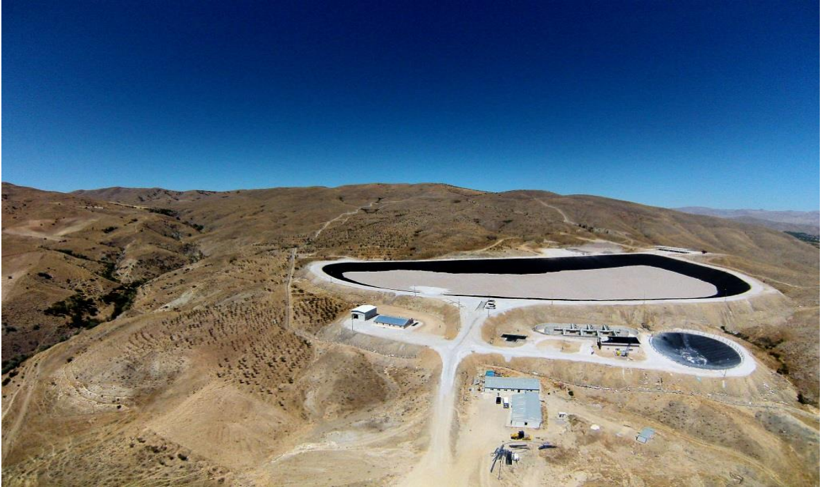
Resim C. 5- İlimiz Katı Atık Bertaraf ve Düzenli Depolama Tesisi İnşaatı
