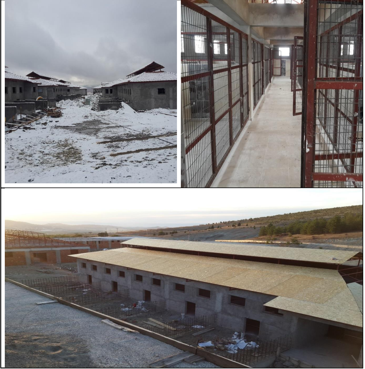
Resim D.8- Hayvan Bakım Evi
