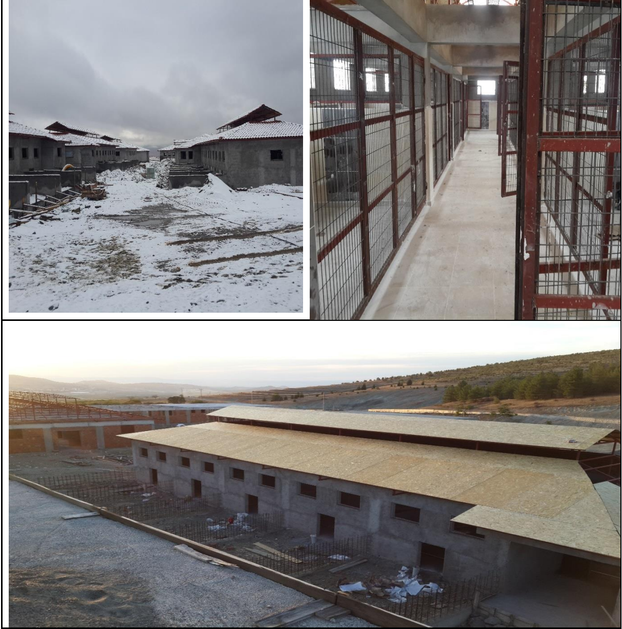
Resim D.8- Hayvan Bakım Evi
