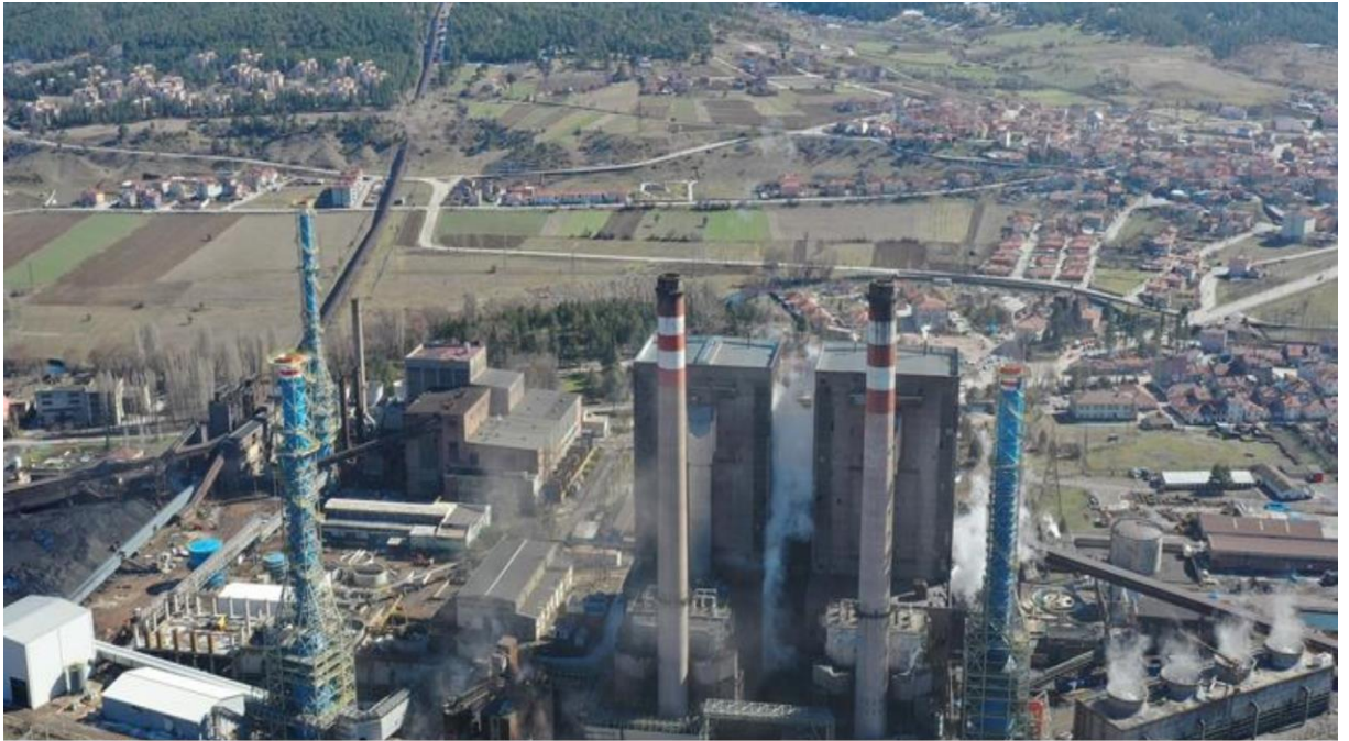
Resim 3- Tunçbilek Termik Santrali
