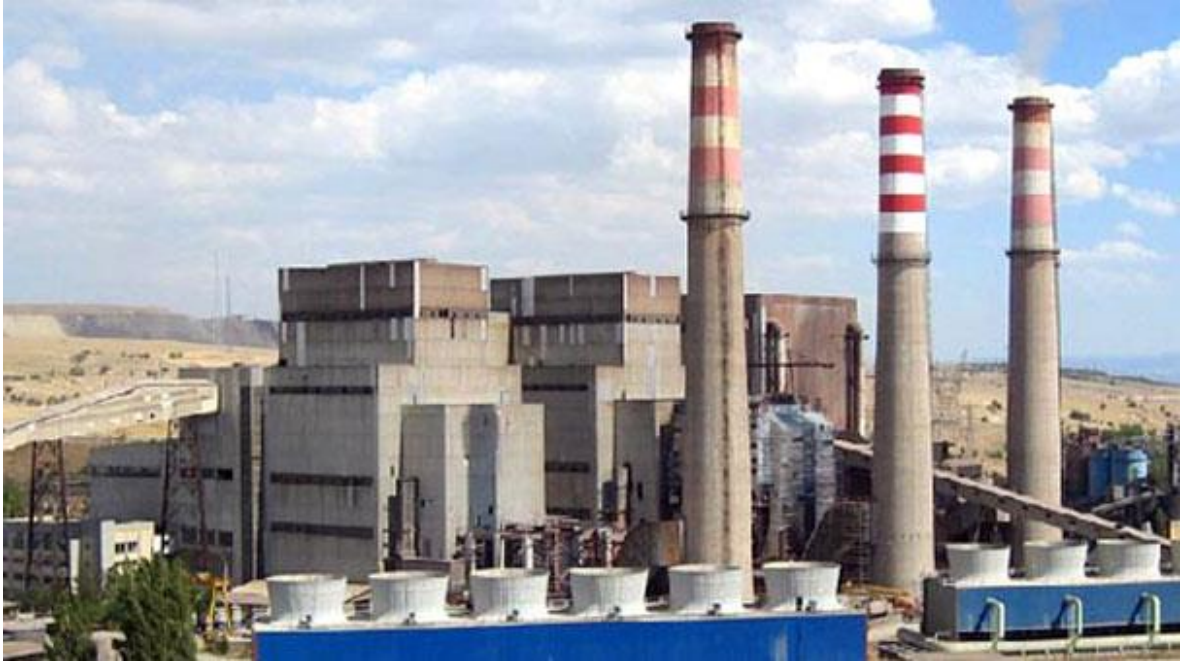
Resim 2– Kütahya ili Çelikler Seyitömer Elektrik Üretim A.Ş Seyitömer Termik Santrali
