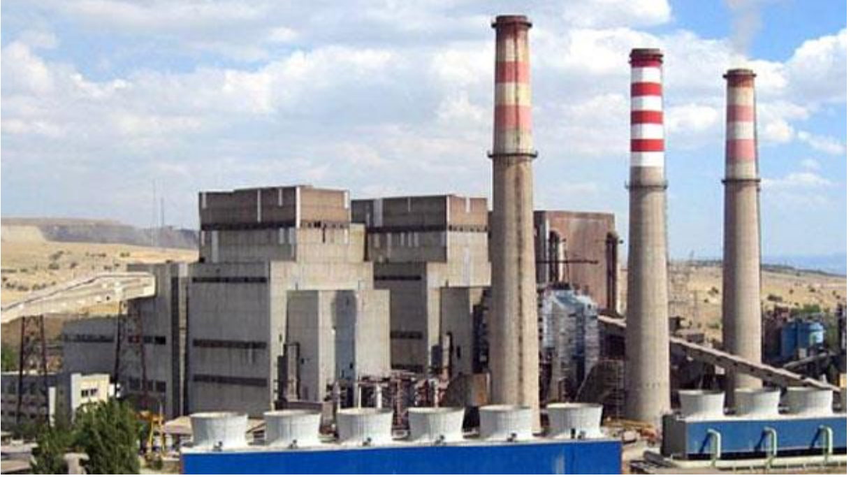
Resim C.2- Kütahya ili Çelikler Seyitömer Elektrik Üretim A.Ş Seyitömer Termik Santrali (ÇEÜAŞ İşletme Müdürlüğü, 2020)
