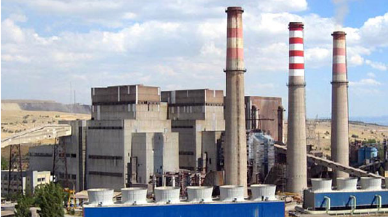
Resim C.2- Kütahya ili Çelikler Seyitömer Elektrik Üretim A.Ş Seyitömer Termik Santrali (ÇEÜAŞ İşletme Müdürlüğü, 2019)
