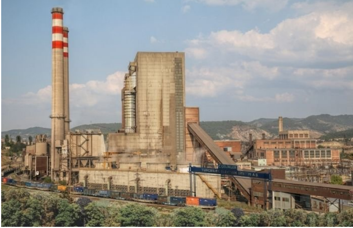
Resim C.3- Çelikler Tunçbilek Termik Santrali (ÇEÜAŞ İşletme Müdürlüğü, 2019)
