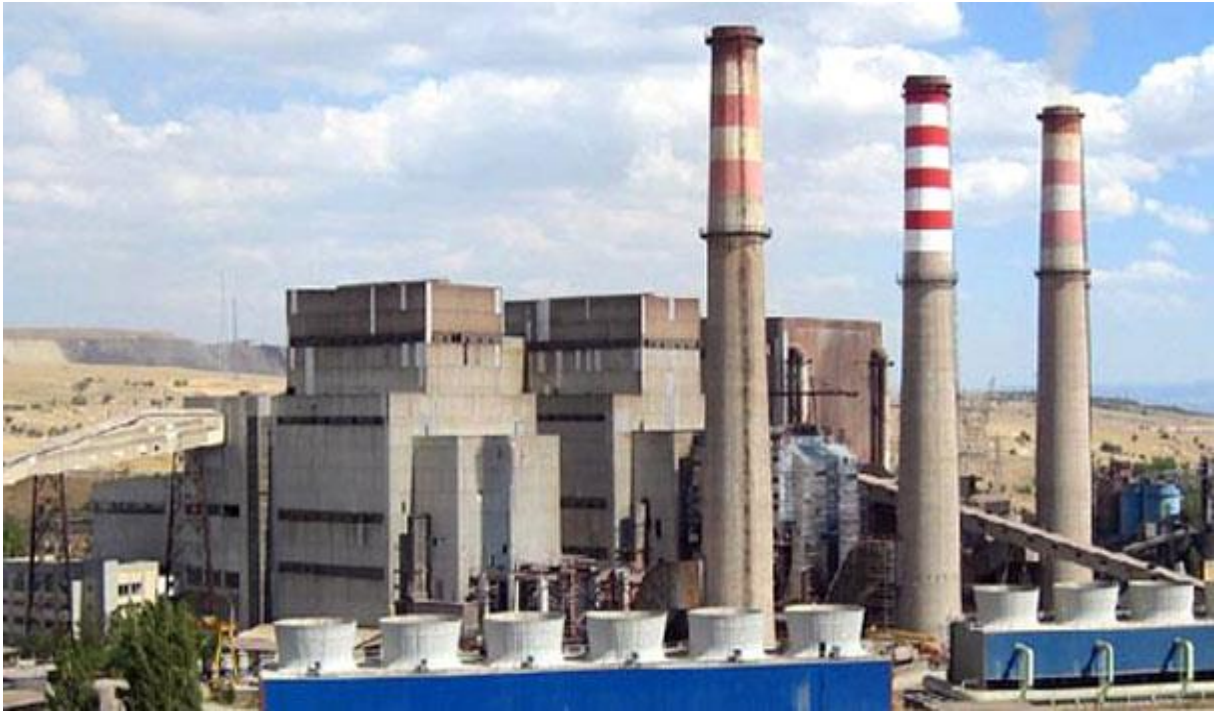
Resim C.2- Kütahya ili Çelikler Seyitömer Elektrik Üretim A.Ş Seyitömer Termik Santrali (ÇEÜAŞ İşletme Müdürlüğü, 2023)
