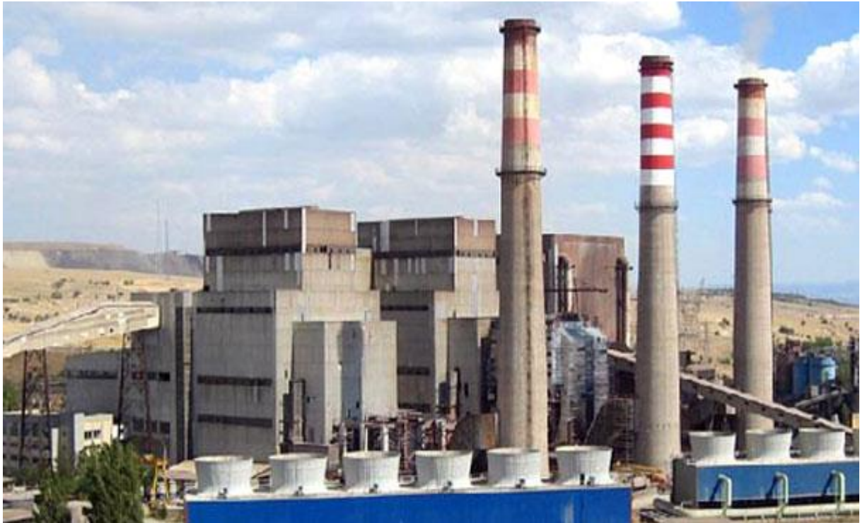
Resim C.2- Kütahya ili Çelikler Seyitömer Elektrik Üretim A.Ş Seyitömer Termik Santrali (ÇEÜAŞ İşletme Müdürlüğü, 2020)
