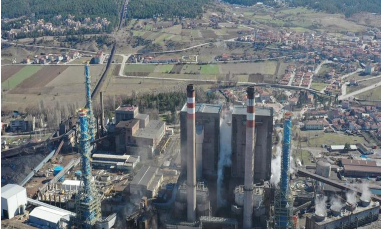
Resim C.3- Tunçbilek Termik Santrali
