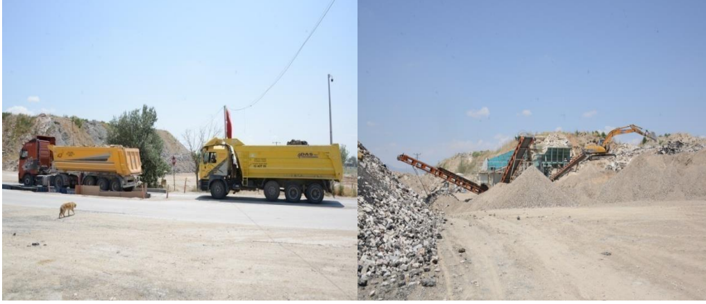
Resim C.13 - Hafriyat Toprağı ve İnşaat Yıkıntı Atıkları Depolama Alanı ve Kırma Eleme Tesisi
