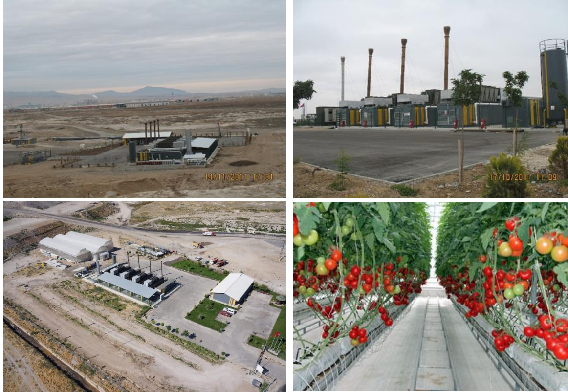
Resim C.10 – Aslım Metan Gazından Elektrik Enerjisi Üretim Tesisi ve Sera
