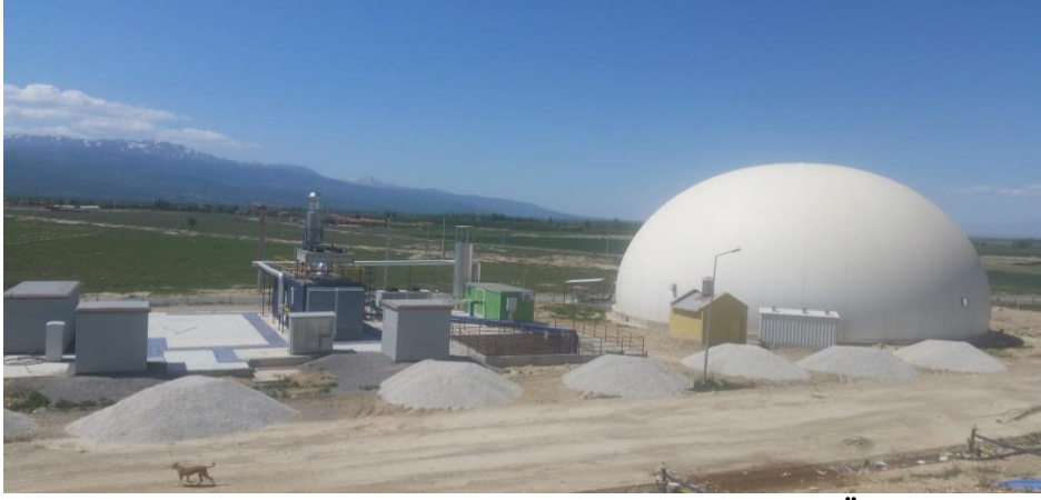
Resim C.11 – Akşehir Metan Gazından Elektrik Enerjisi Üretim Tesisi
