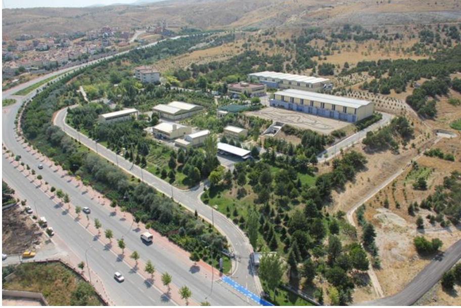
Resim B.2 – Konya içme suyu arıtma tesisi (KOSKİ, 2019)
