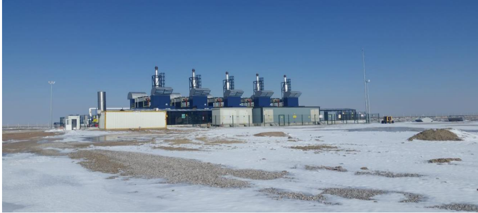
Resim C.12 – Kaşınhanı Metan Gazından Elektrik Enerjisi Üretim Tesisi
