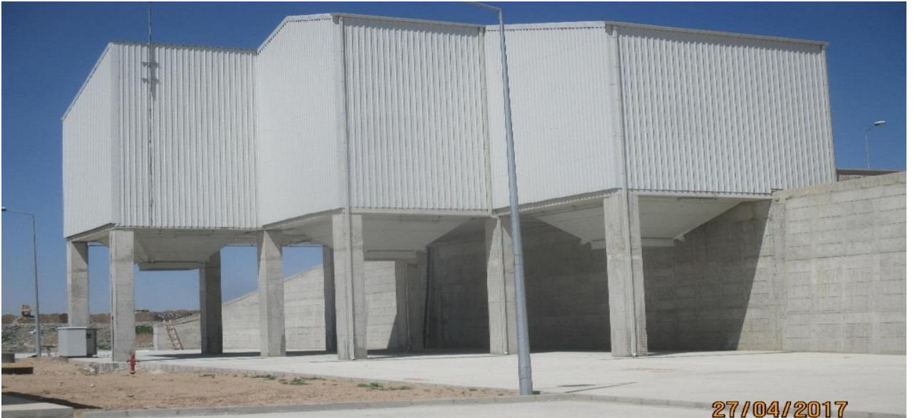
Resim C.5 -Aslım Katı Atık Transfer İstasyonu
