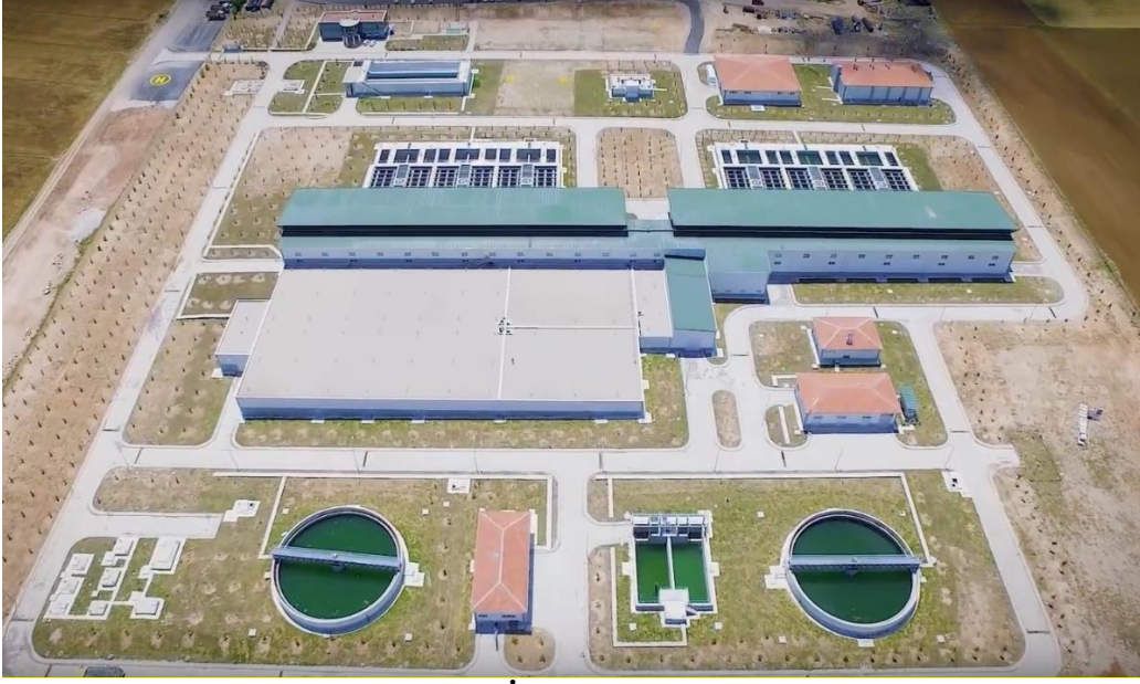
Resim 1 – Seçme İçme Suyu Arıtma Tesisi (KOSKİ, 2025)
