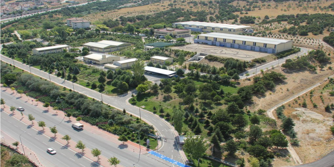
Resim 2– Akyokuş İçme Suyu Arıtma Tesisi (KOSKİ, 2025)
