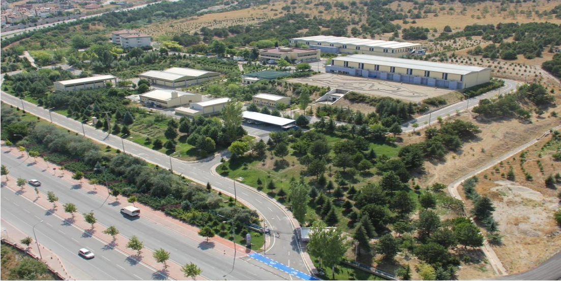
Resim 2– Akyokuş İçme Suyu Arıtma Tesisi (KOSKİ, 2025)
