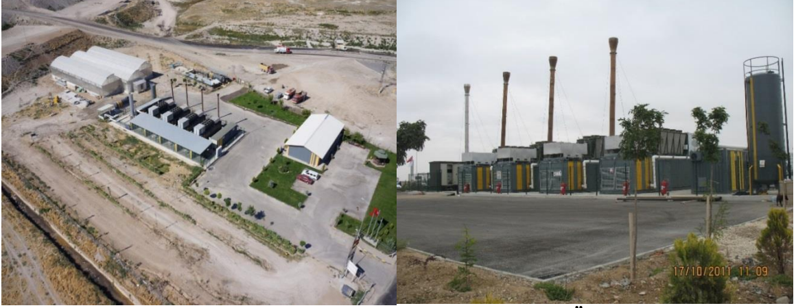
Resim 13– Aslım Metan Gazından Elektrik Enerjisi Üretim Tesisi (Konya Büyükşehir Belediyesi, 2025)
