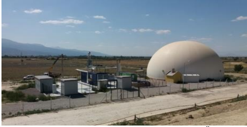
Resim 14– Akşehir Metan Gazından Elektrik Enerjisi Üretim Tesisi (Konya Büyükşehir Belediyesi, 2025)
