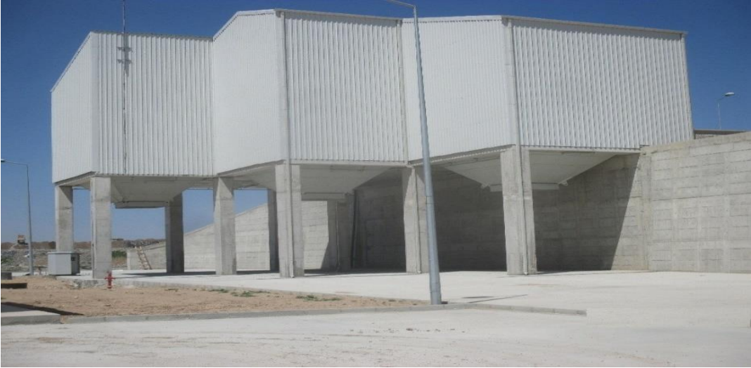
Resim 6– Aşım Katı Atık Transfer İstasyonu (Konya Büyükşehir Belediyesi, 2025)
