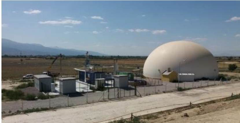
Resim.14 – Akşehir Metan Gazından Elektrik Enerjisi Üretim Tesisi (Konya Büyükşehir Belediyesi, 2024)
