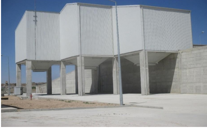
Resim.6 – Aslım Katı Atık Transfer İstasyonu (Konya Büyükşehir Belediyesi, 2024)
