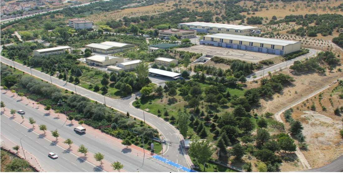
Resim. 2 – Akyokuş İçme Suyu Arıtma Tesisi (KOSKİ, 2024)
