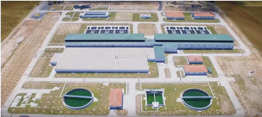
Resim.1 – Seçme İçme Suyu Arıtma Tesisi (KOSKİ, 2024)
