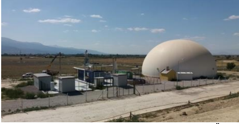
Resim C.14 – Akşehir Metan Gazından Elektrik Enerjisi Üretim Tesisi (Konya Büyükşehir Belediyesi, 2023)
