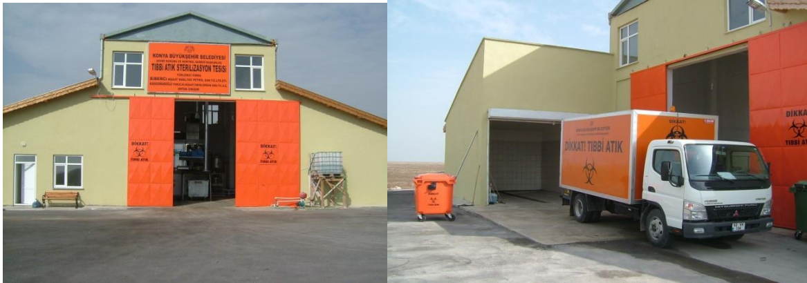
Resim C.25 – Tıbbi Atık Sterilizasyon Tesisi (Konya Büyükşehir Belediyesi, 2023)
