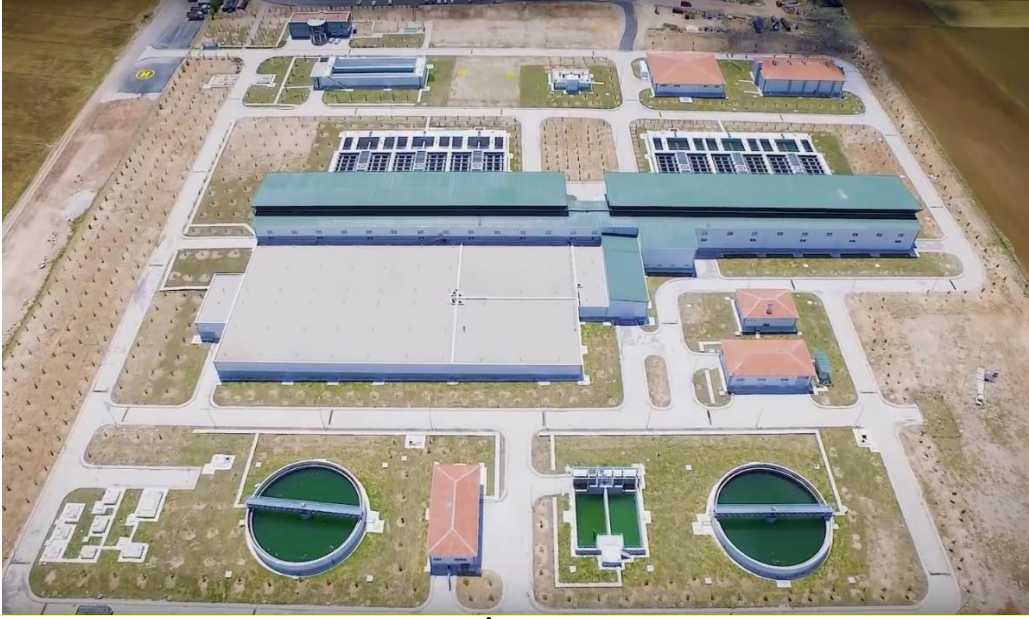
Resim C.1 – Seçme İçme Suyu Arıtma Tesisi (KOSKİ, 2023)
