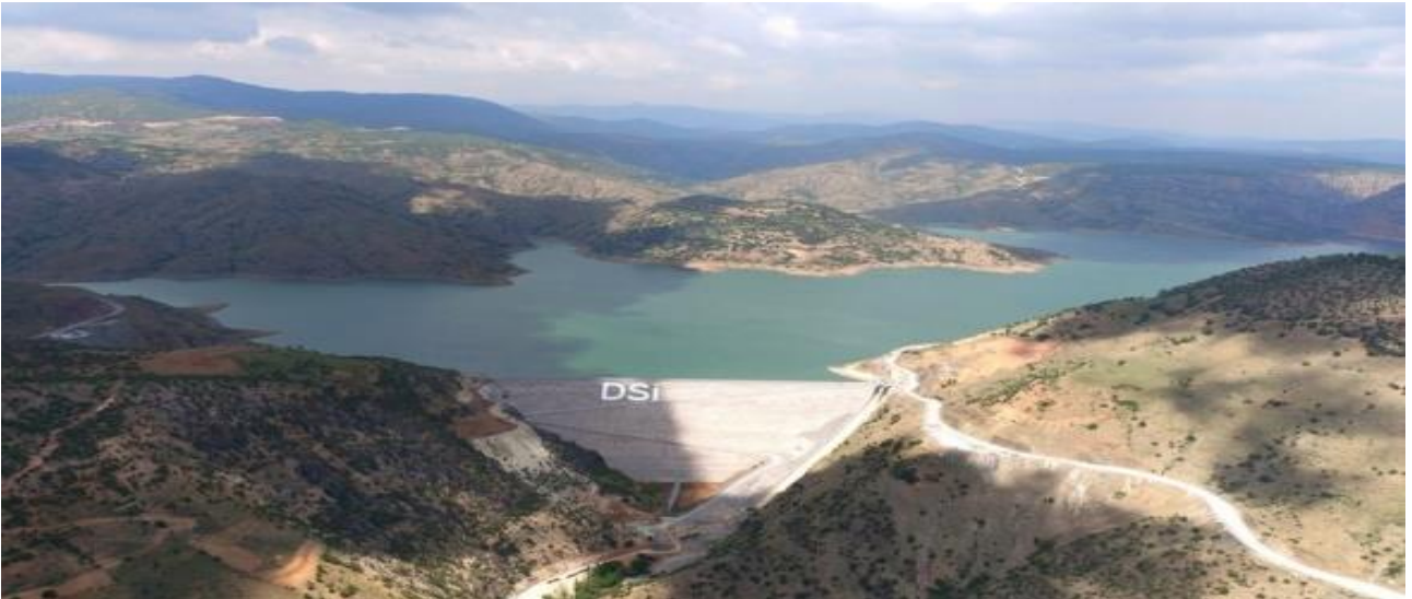
Resim C.4 – Bağbaşı Barajı (KOSKİ, 2023)
