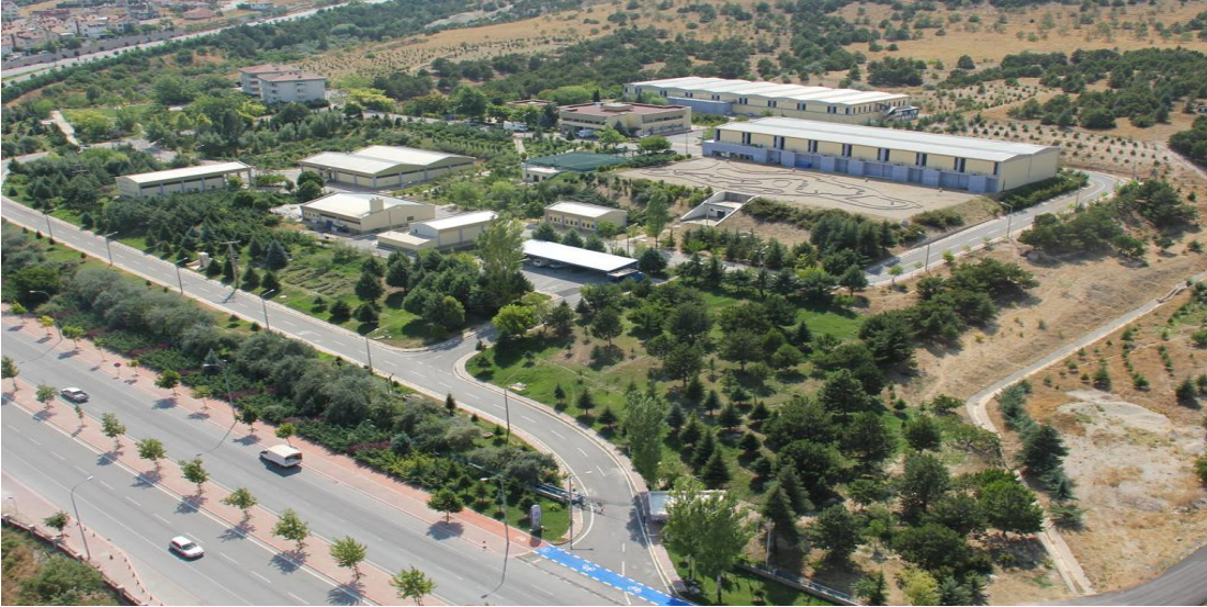
Resim C.2 – Akyokuş İçme Suyu Arıtma Tesisi (KOSKİ, 2023)
