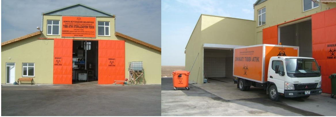
Resim C.26 – Tıbbi Atık Sterilizasyon Tesisi (Konya Büyükşehir Belediyesi, 2022)
