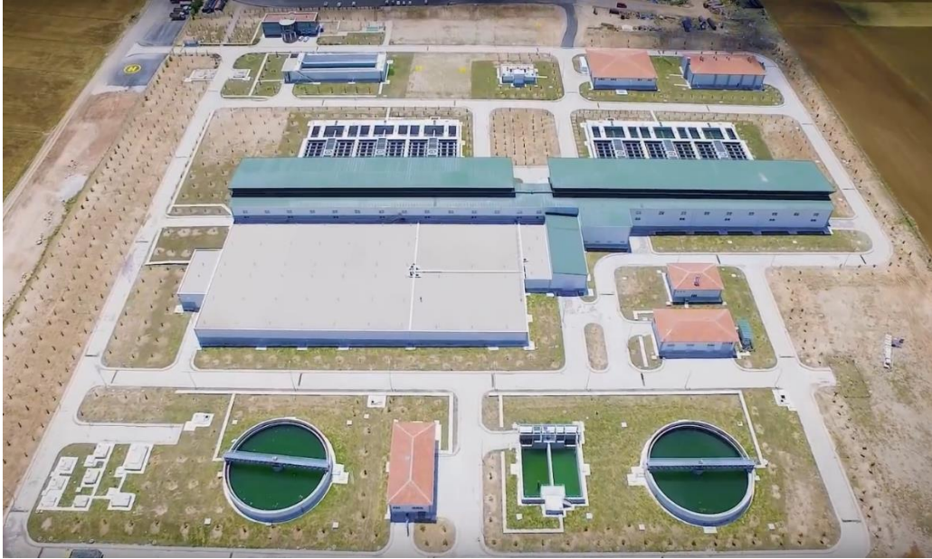
Resim C.1 – Seçme İçme Suyu Arıtma Tesisi (KOSKİ, 2022)
