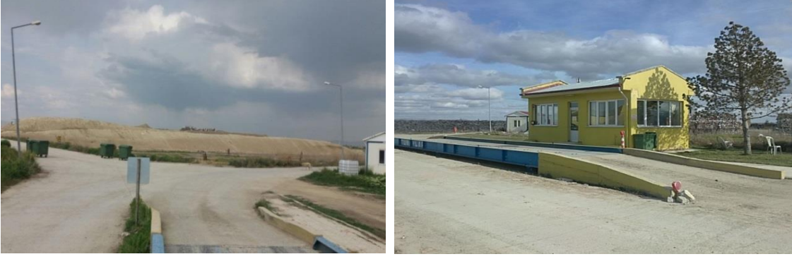
Resim C.12 – Akşehir Katı Atık Düzenli Depolama Sahası (Konya Büyükşehir Belediyesi, 2022)
