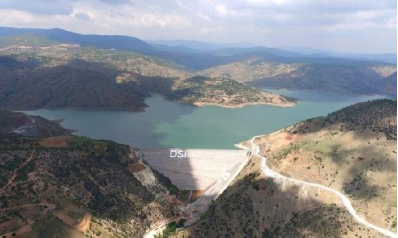
Resim C.4 – Bağbaşı Barajı (KOSKİ, 2022)
