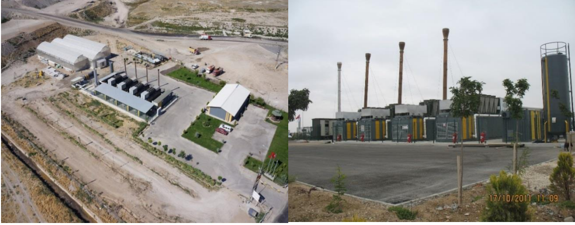
Resim C.13 – Aslım Metan Gazından Elektrik Enerjisi Üretim Tesisi (Konya Büyükşehir Belediyesi, 2022)
