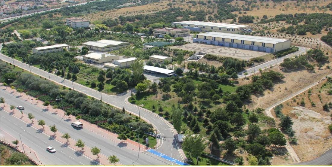
Resim C.2 – Akyokuş İçme Suyu Arıtma Tesisi (KOSKİ, 2022)
