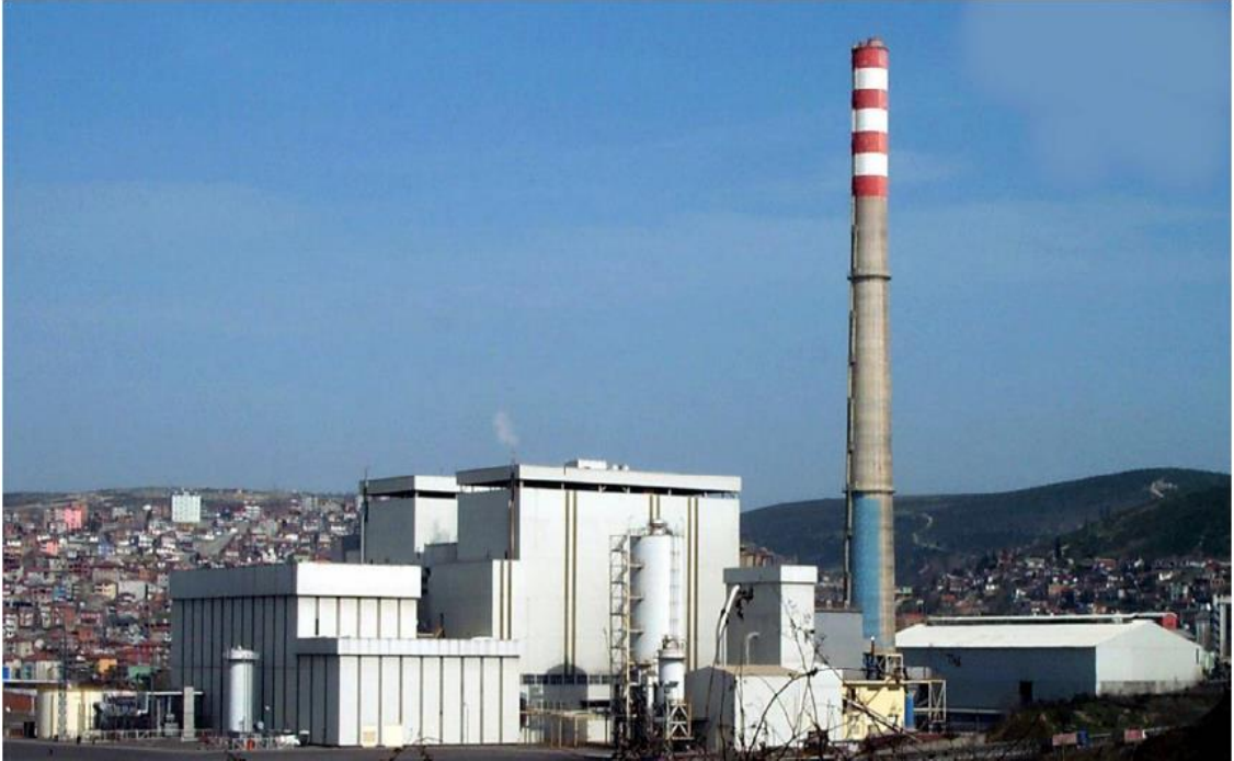
Resim C.3 – Çolakoğlu Metalurji A.Ş. Termik Santrali (Çolakoğlu Metalurji A.Ş., 2019)
