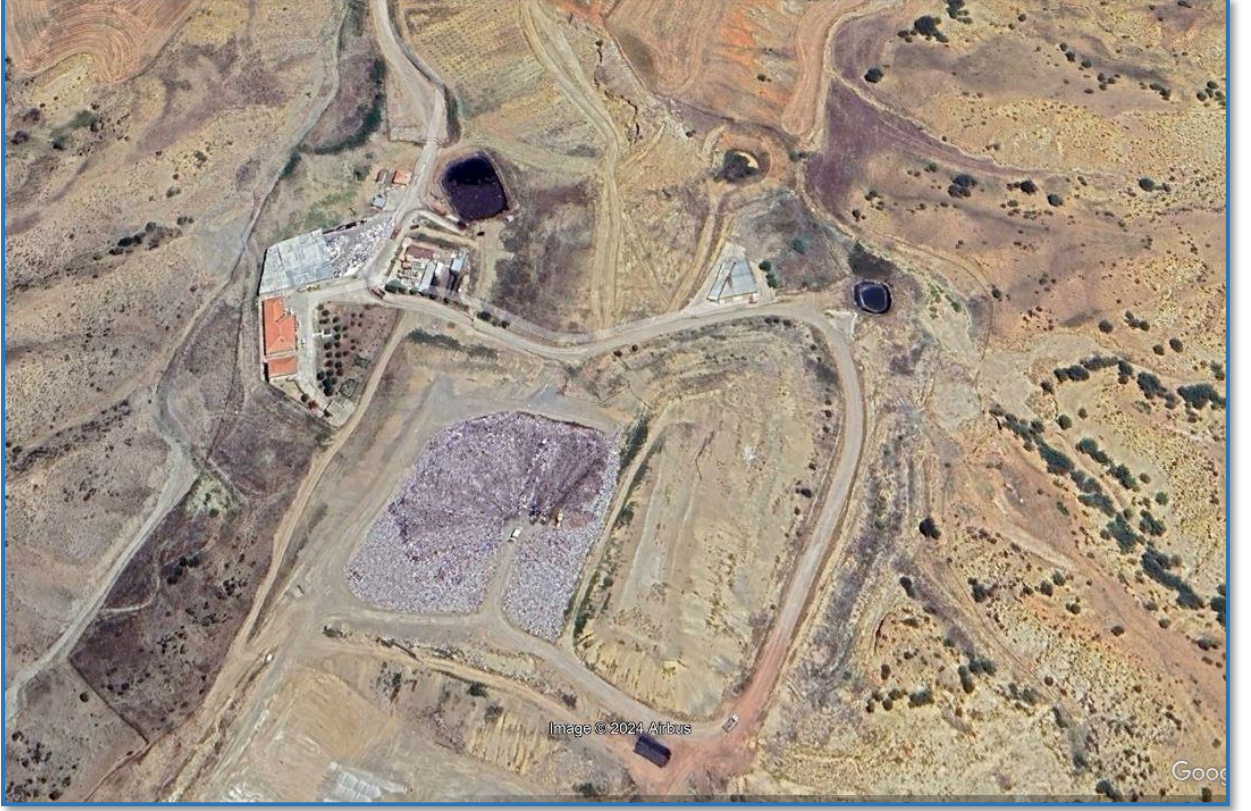
Resim 3 – Kırıkkale Katı Atık Depolama Tesisi Uydu Görüntüsü (Kaynak: Google Earth)
