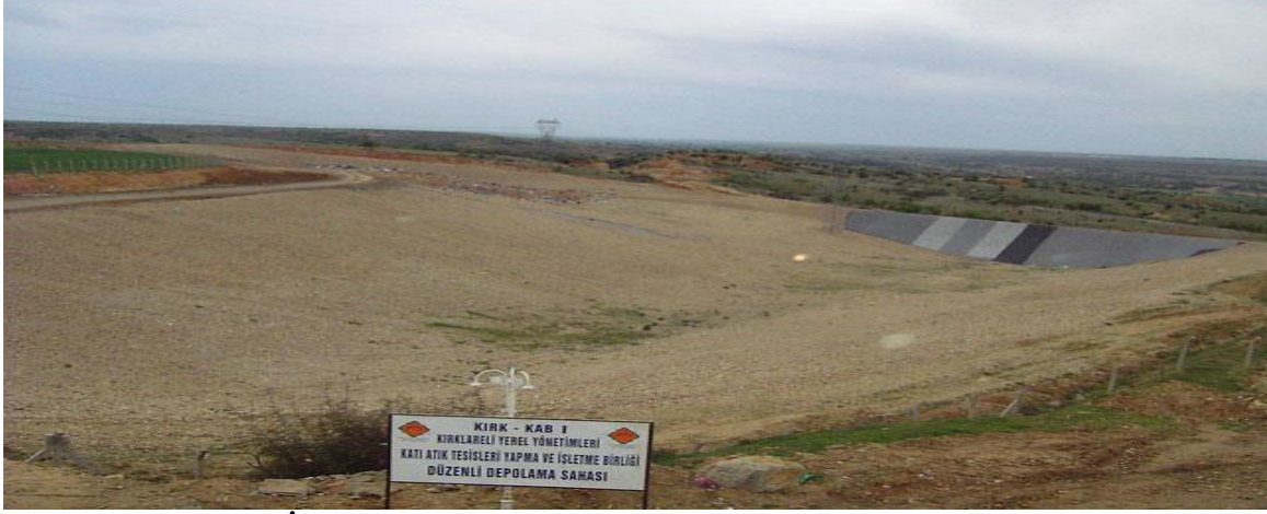
Resim 1 - Kırklareli İli Katı Atık Bertaraf Tesisi
