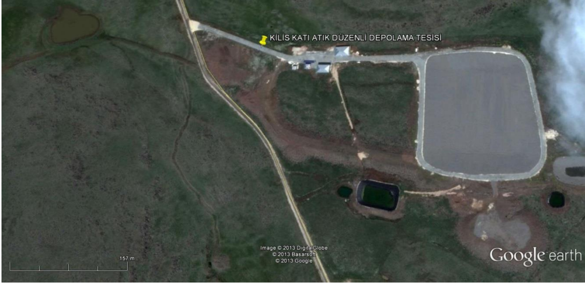
Katı Atık Düzenli Depolama Alanı
