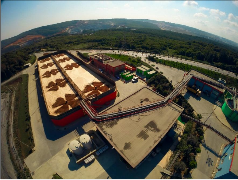
Resim C.4 – Odayeri Sızıntı Suyu Arıtma Tesisi (İBB, 2023)
