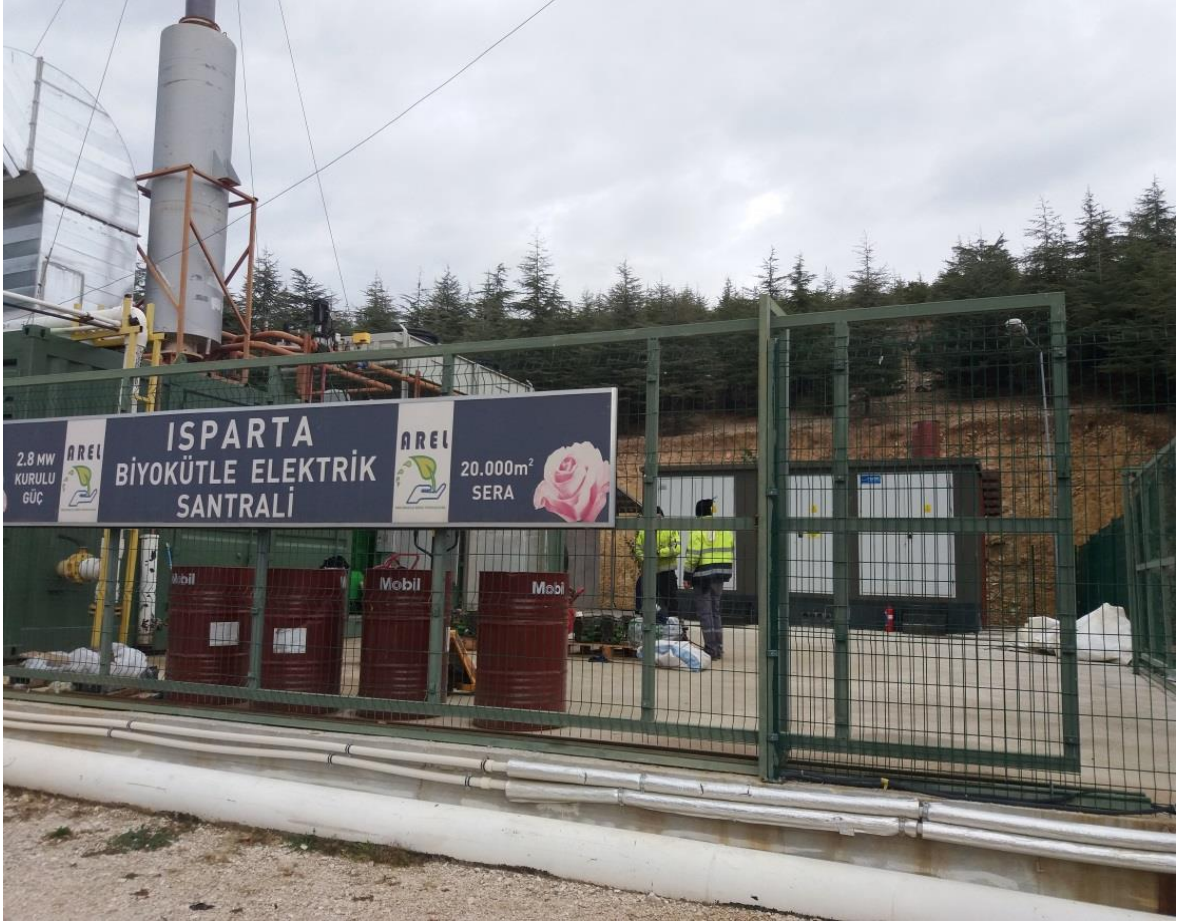
Resim C.22- Göller Bölgesi Belediyeler Birliğine Ait Koçtepe Düzenli Katı Atık Depolama Tesisi İçerisinde Yer Alan Depo Gazı Enerji Üretim Santrali
