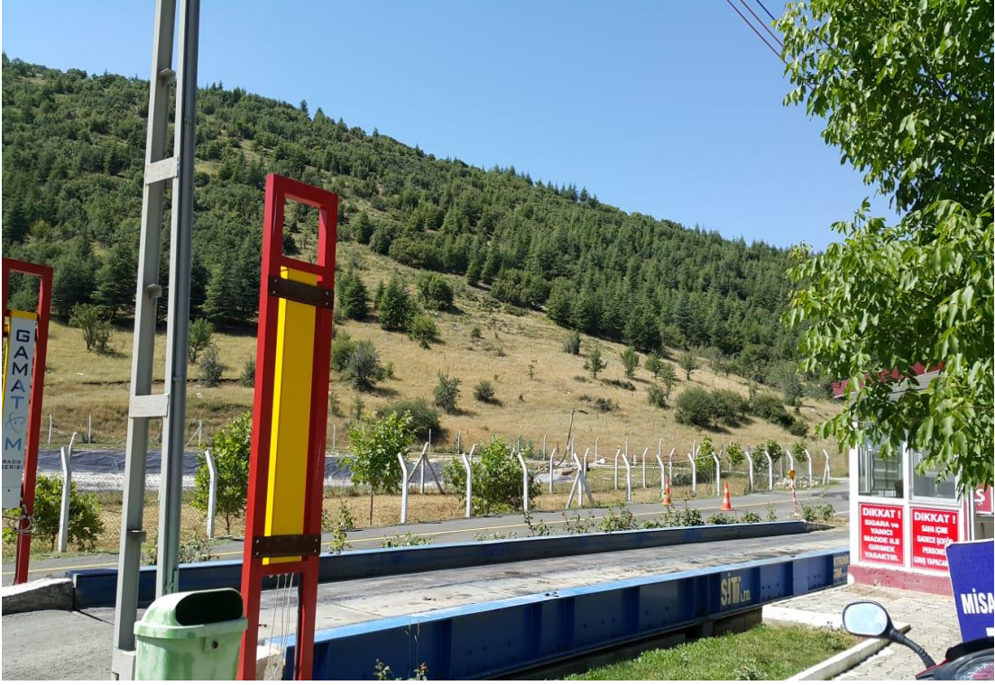
Resim C.4 – Göller Bölgesi Belediyeler Birliğine ait Koçtepe Düzenli Katı Atık Depolama Tesisi kantar ünitesi
