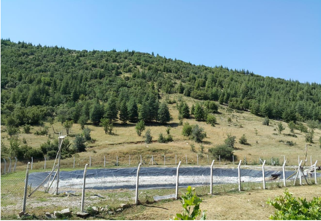
Resim C.6 – Gller Blgesi Belediyeler Birliđine ait Koçtepe Dzenli Katı Atık Depolama Tesisi sızıntı suyu toplama havuzu
