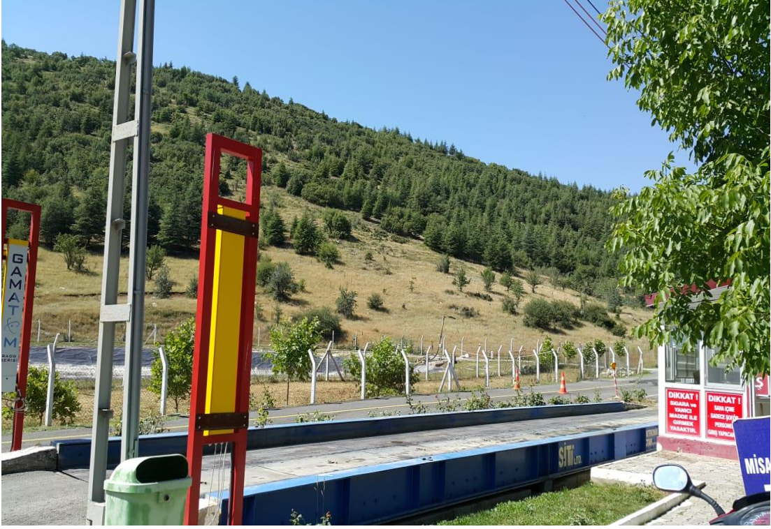
Resim C.5 - Göller Bölgesi Belediyeler Birliğine ait Koçtepe Düzenli Katı Atık Depolama Tesisi kantar ünitesi
