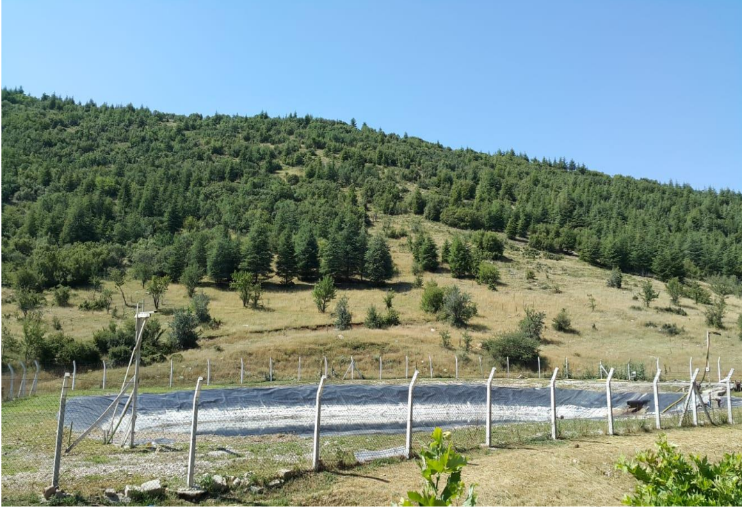
Resim C.7 - Göller Bölgesi Belediyeler Birliğine ait Koçtepe Düzenli Katı Atık Depolama Tesisi sızıntı suyu toplama havuzu
