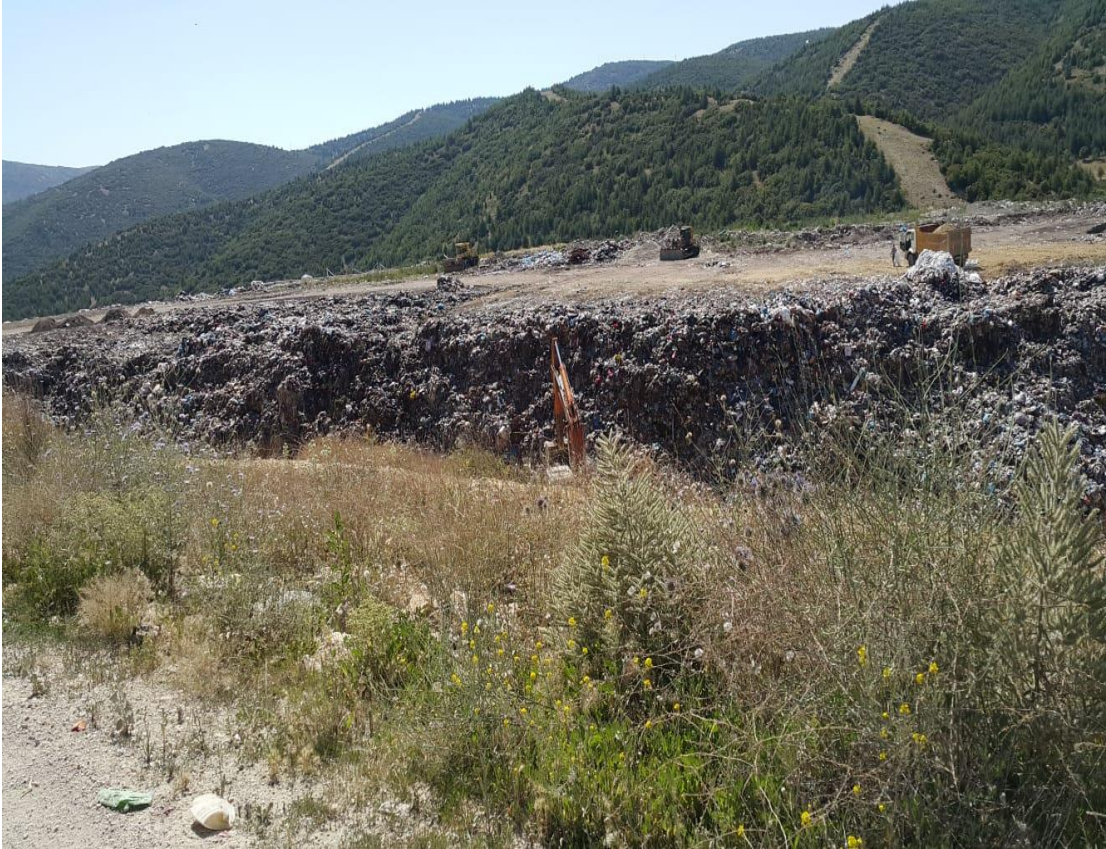
Resim C.6 - Göller Bölgesi Belediyeler Birliğine ait Koçtepe Düzenli Katı Atık Depolama Tesisi depolama alanı
