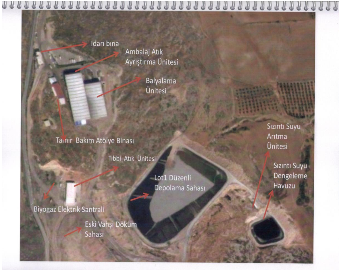
Harita B.3 - Hatay Katı Atık Düzenli Depolama Tesisi
