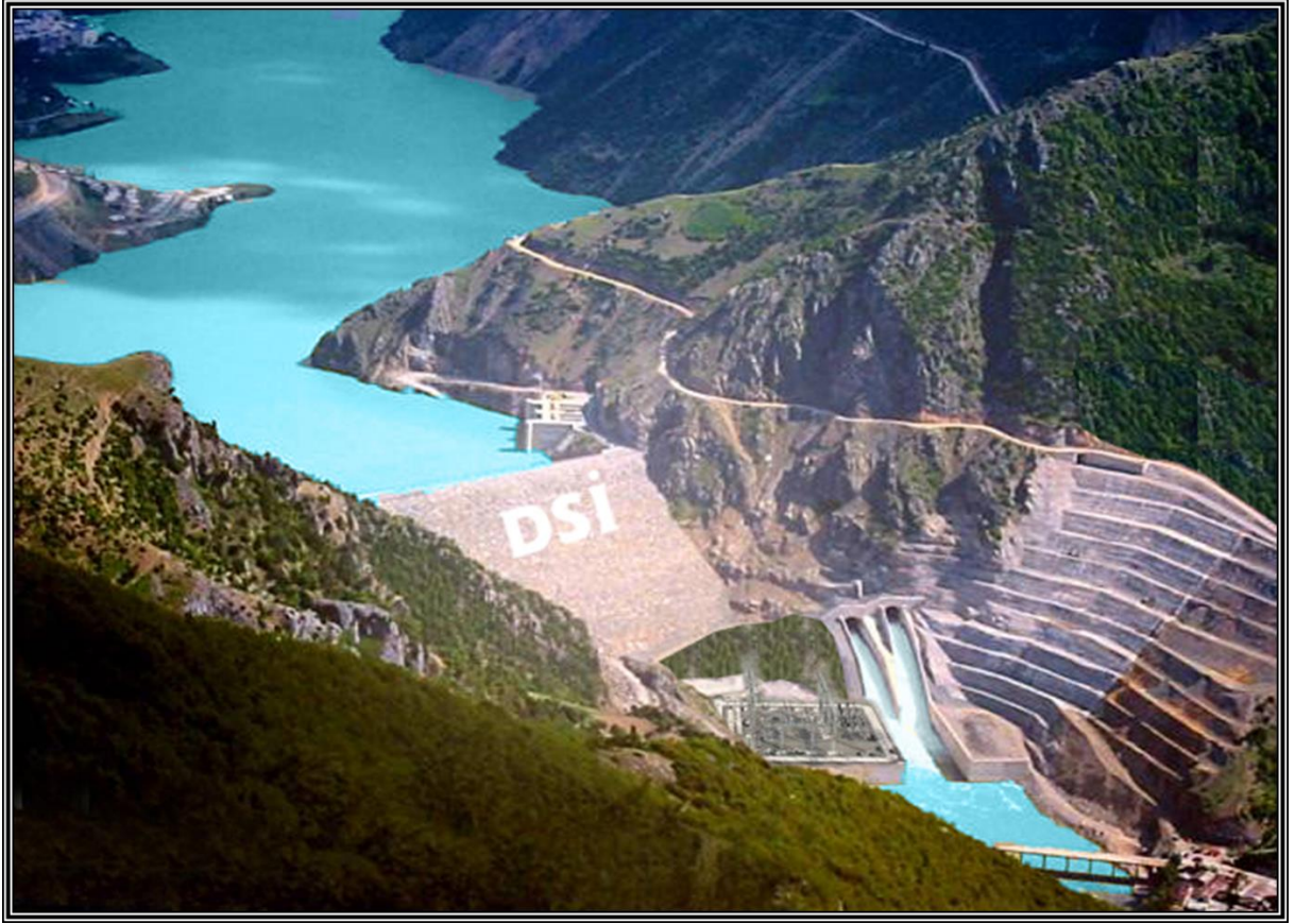
Resim B.3- Kürtün Barajı
