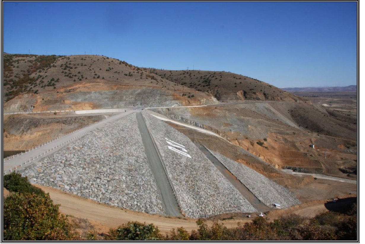
Resim B.1- Köse Barajı
