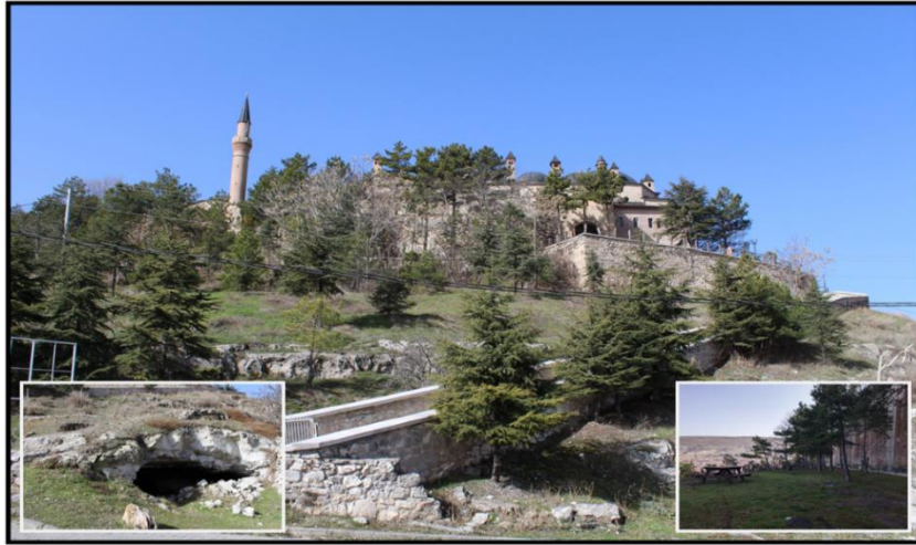
Resim 60-Battalgazi Külliyesi (Eskişehir Çevre, Şehircilik ve İklim Değişikliği İl Müdürlüğü)
