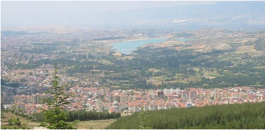
Resim B.5 - Gökpınar Barajı Su Toplama Havzası ve Baraj Gölünün Menbattan Görünüşü
