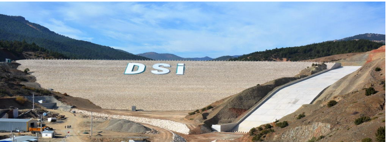
Resim B.7 - Acıpayam Akalan Barajı
