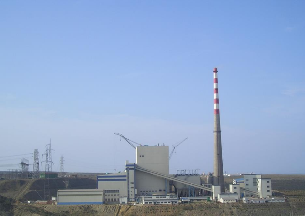
Resim C. 5 Değirmencik Termik Santrali ( İçdaş) (İçdaş Demir Çelik Üretim,2019)
