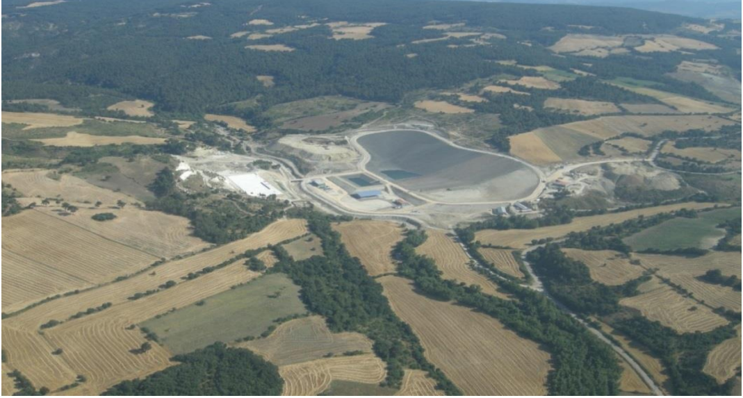
Resim C. 1- Katı Atık Düzenli Depolama Tesisi (Doğantepe Mevkii-Kemel Köyü, Ç.KALE)
