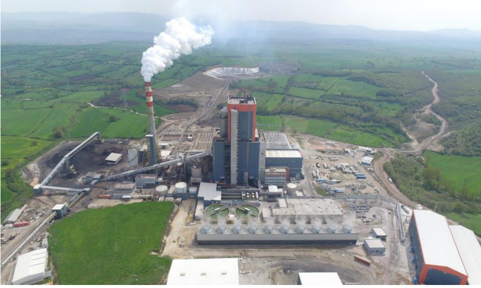
Resim C. 6 - Çan-2 Termik Santrali (ODAŞ) (Çan -2 Termik Santrali, 2019)
