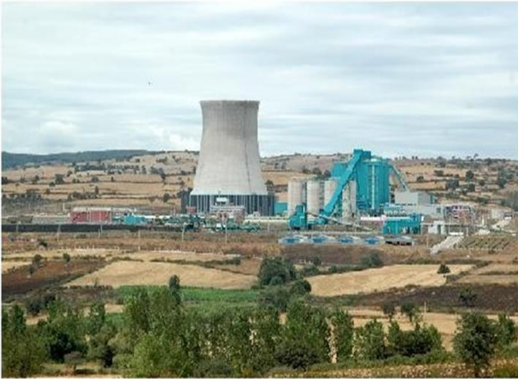
Resim 4- 18 Mart Çan Termik Santrali, ( Çan Termik Santrali, 2019 )
