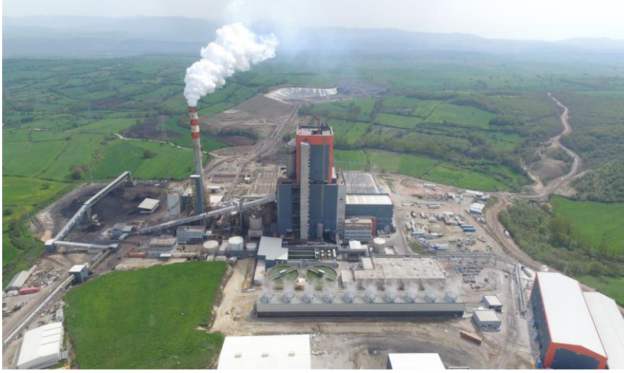
Resim 7- Çan-2 Termik Santrali (ODAŞ), (Çan -2 Termik Santrali, 2019)
