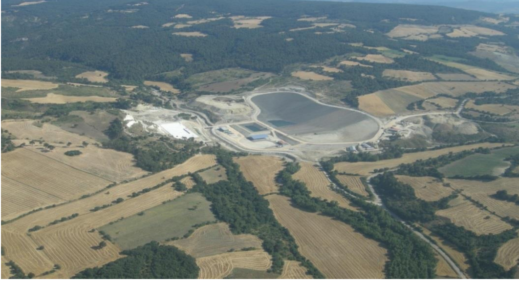
Resim 2- Katı Atık Düzenli Depolama Tesisi (Doğantepe Mevkii-Kemel Köyü, Çanakkale)
