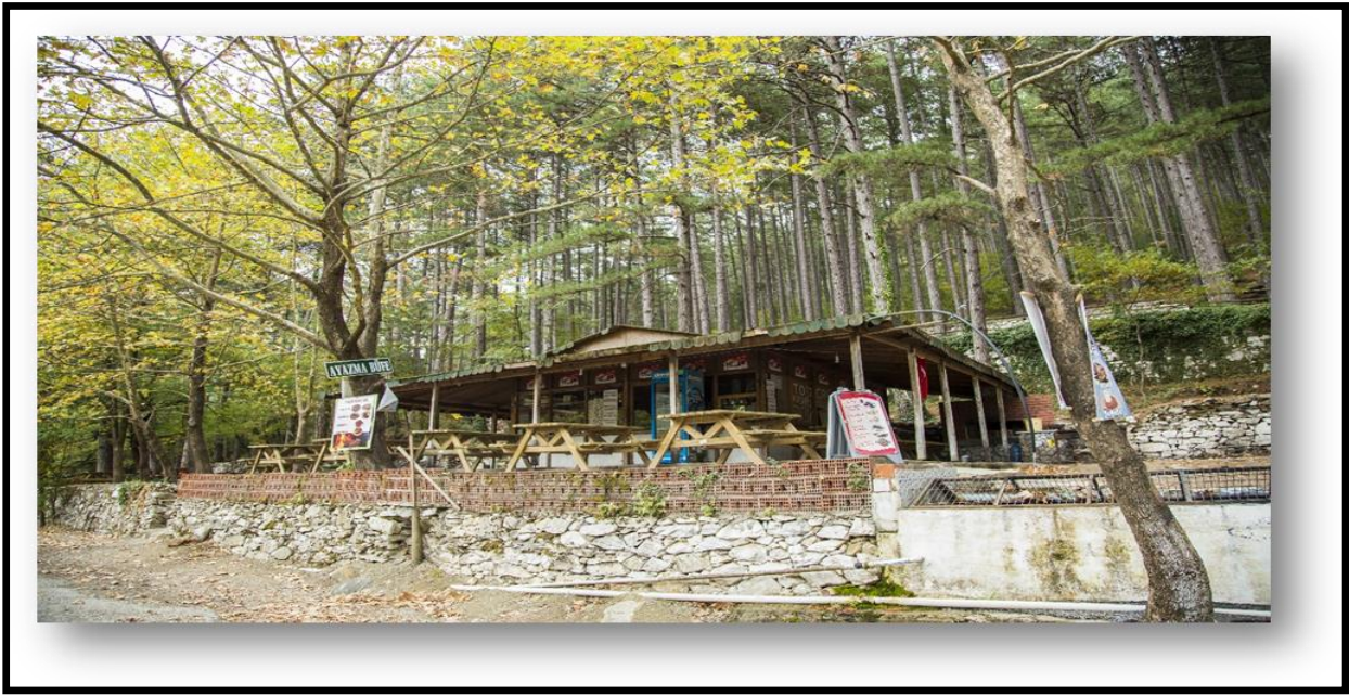
Resim D.70- Ayazmapınarı Büfe (Tarım ve Orman Bakanlığı 2. Bölge Müdürlüğü Çanakkale Şube Müdürlüğü, 2022)
