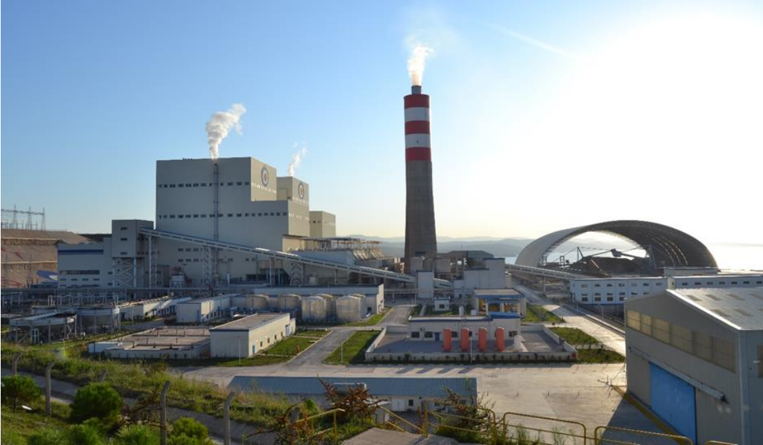
Resim C.5- Bekirli Termik ( İçdaş) Santrali (İçdaş Elektrik Üretim,2019)
