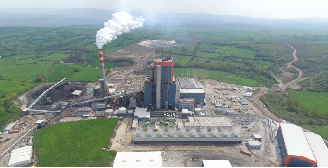
Resim C.7- Çan-2 Termik Santrali (ODAŞ) (Çan -2 Termik Santrali, 2019)
