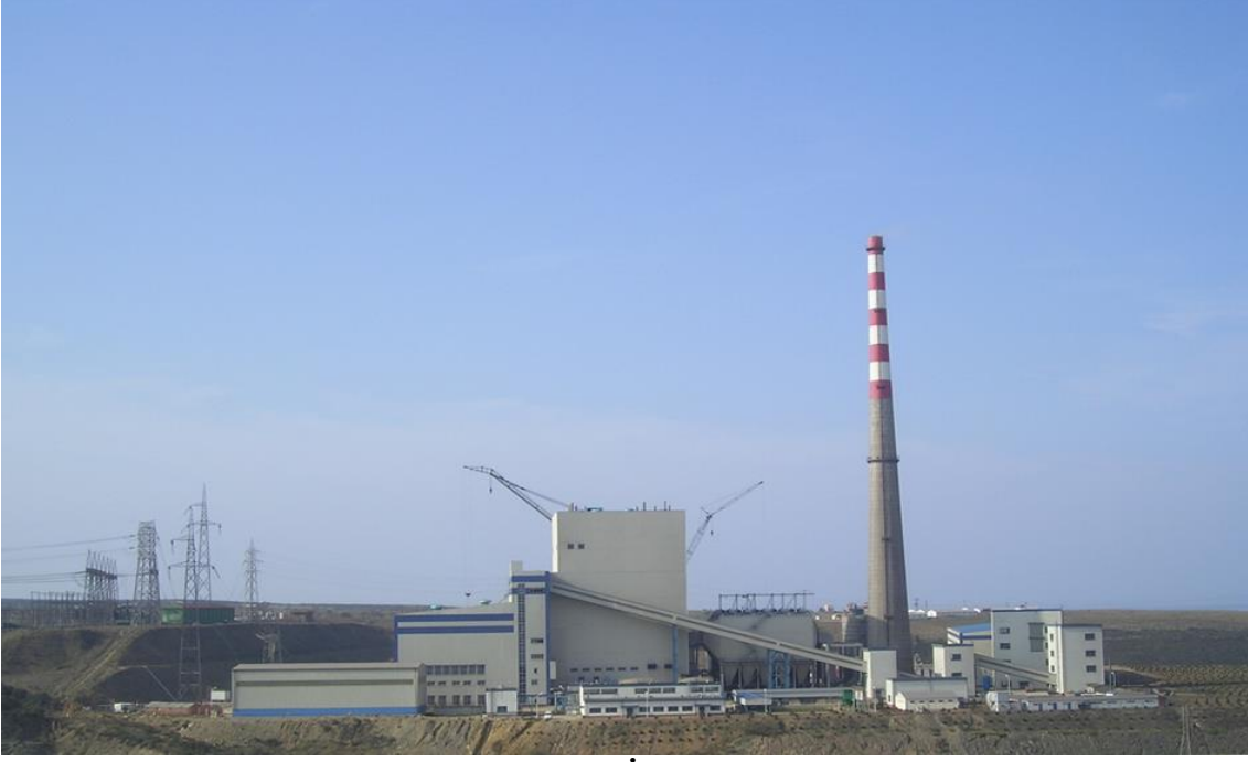
Resim C.6- Değirmencik Termik Santrali ( İçdaş) (İçdaş Demir Çelik Üretim,2019)
