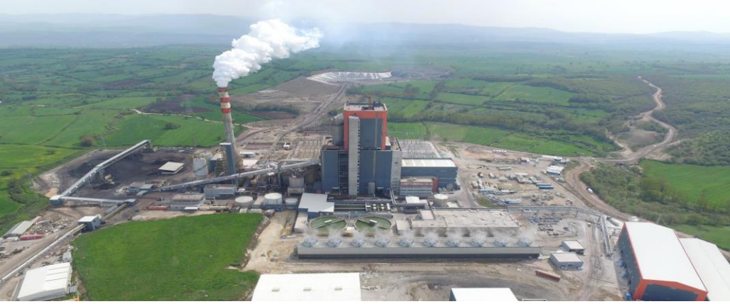
Resim C6 Çan-2 Termik Santrali ( ODAŞ) ( Çan -2 Termik Santrali ,2019)
