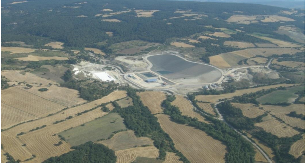
Resim C.21 Katı Atık Düzenli Depolama Tesisi (Doğantepe Mevkii-Kemel Köyü, Ç.KALE)
