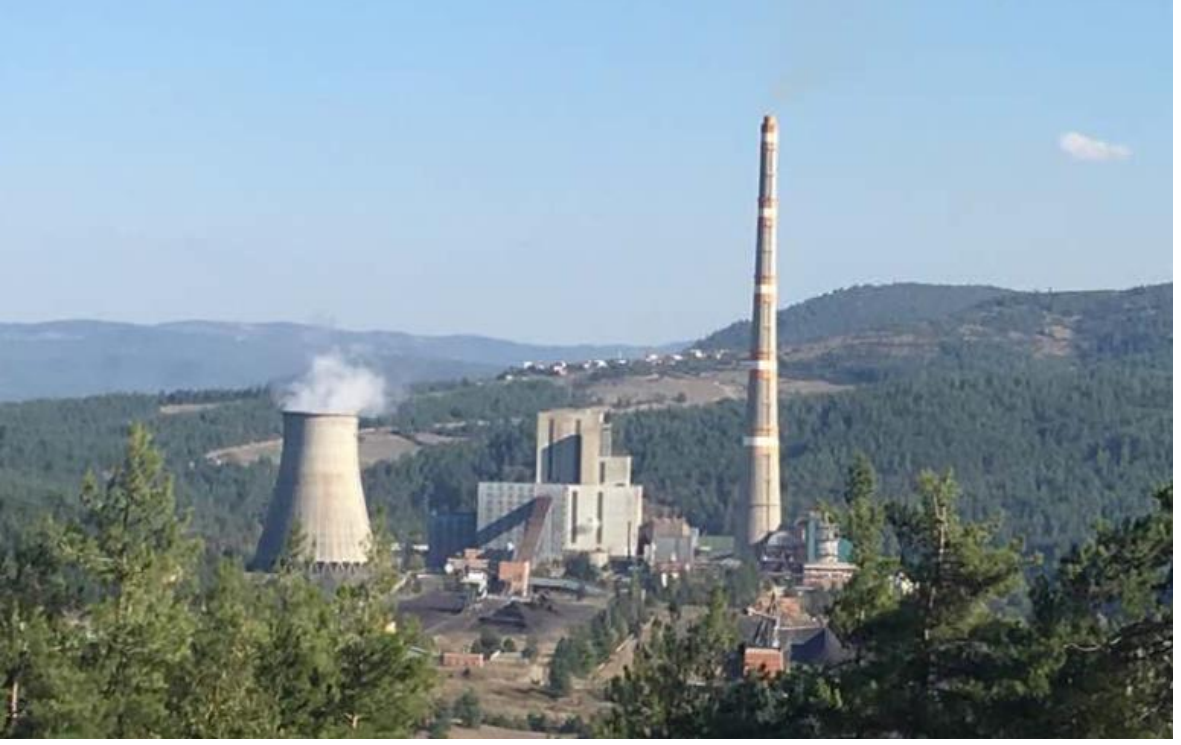
Resim C.1 – Çelikler Orhaneli Termik Santrali (BÇŞİM, 2017)
