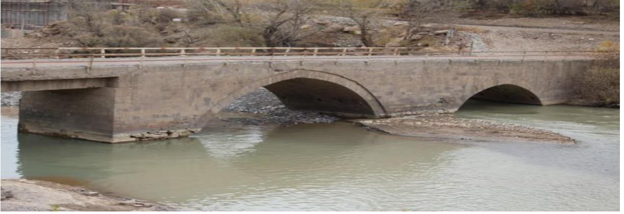
Resim.40-Kığı Selenk Köprüsü
