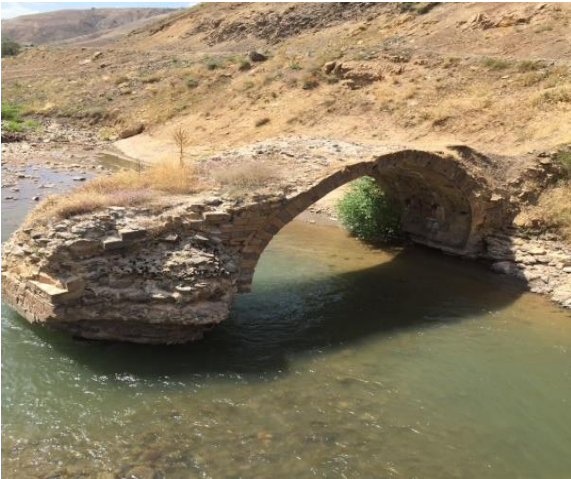
Resim D.30-Karlıova Osmanlı Köprüsü
